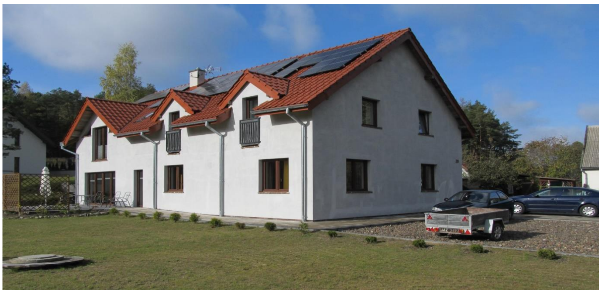
Zdjęcie 1. Istniejąca zabudowa
