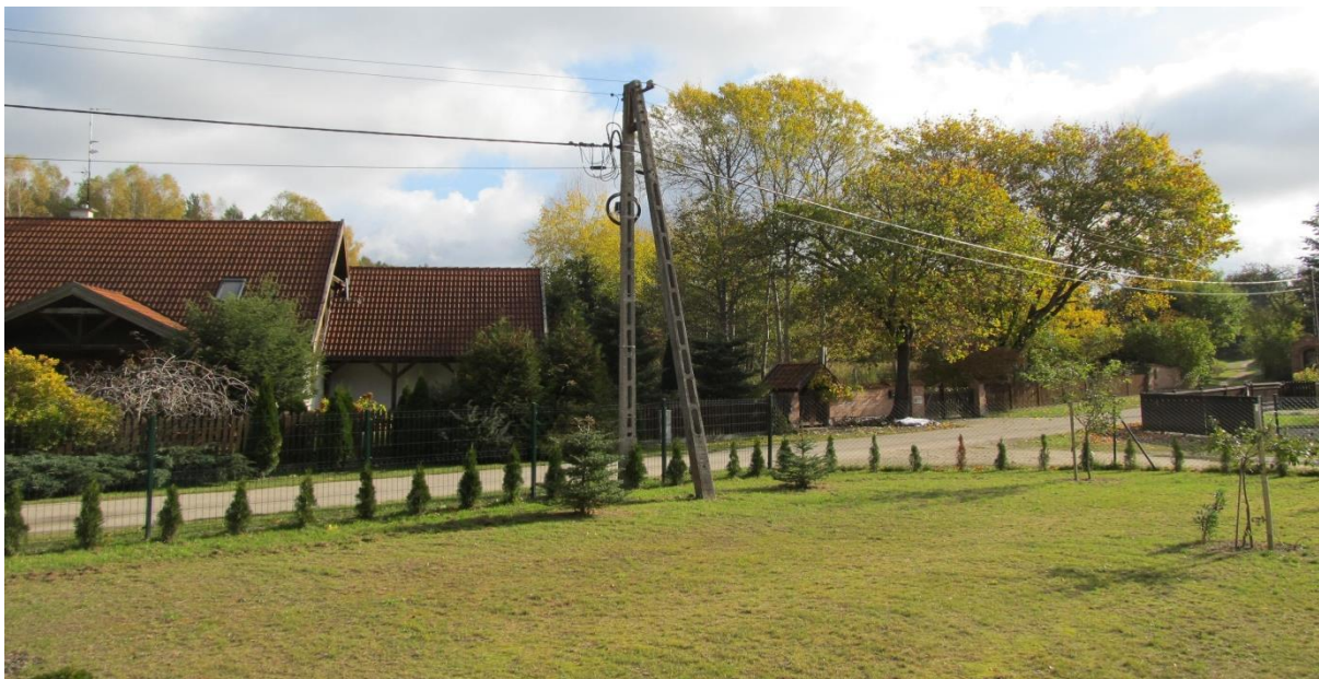
Zdjęcie 4. Linia elektroenergetyczna niskiego napięcia
