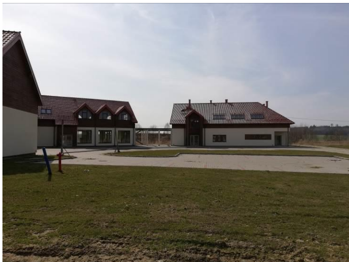
Zdjęcie. Budynki usługowe w trakcie budowy na terenie objętym opracowaniem.
