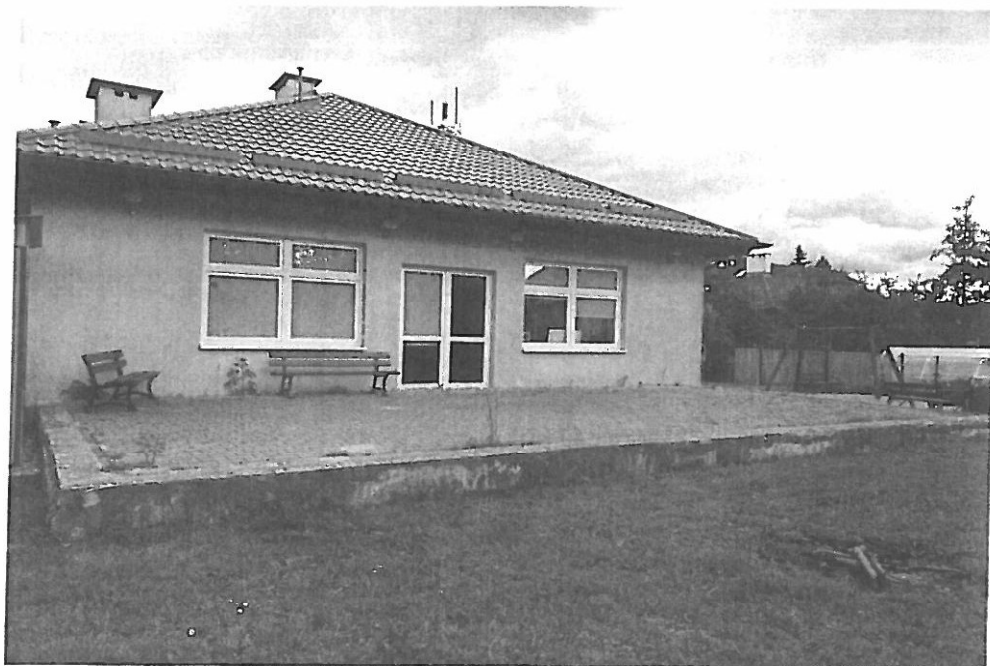
Zdj. 4 Istniejący taras przy świetlicy na którym planowana jest altana.
