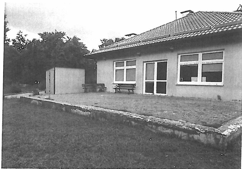
Zdj. 3 Istniejący taras przy świetlicy na którym planowana jest altana.
