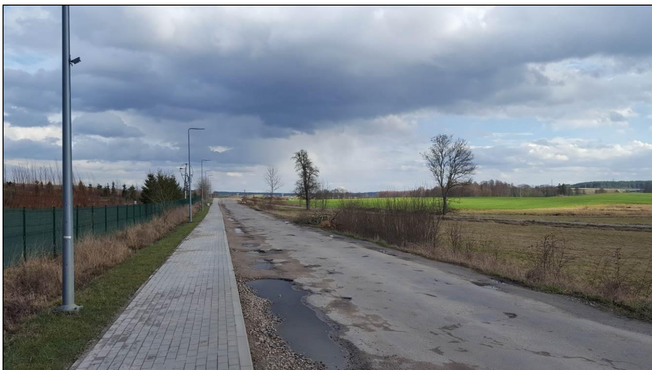
Fot. 4 Widok na drogę publiczną powiatową obsługującą obszar opracowania (fot. własna)
