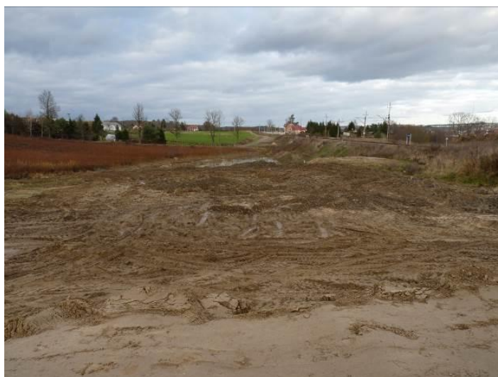
Zdjęcie. Teren przekształcony w wyniku prowadzonych robót budowlanych w części północnej obszaru objętego projektem planu.
