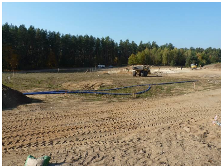
Zdjęcie. Budowa budynku usługowego na działce nr ewid. 24/14 na terenie oznaczonym symbolem UP.02 na rysunku projektu planu; na drugim planie las oznaczony symbolem ZL.01 na rysunku projektu planu.
