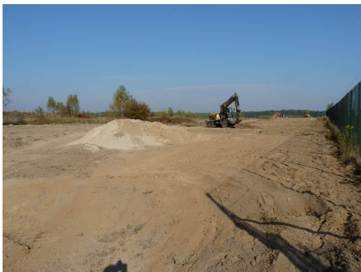
Zdjęcie. Budowa sieci infrastruktury technicznej w ulicy Jarzębinowej stanowiącą granicę terenu objętego opracowaniem; po prawej stronie widoczne ogrodzenie sąsiedniej działki zabudowanej budynkiem usługowym.
