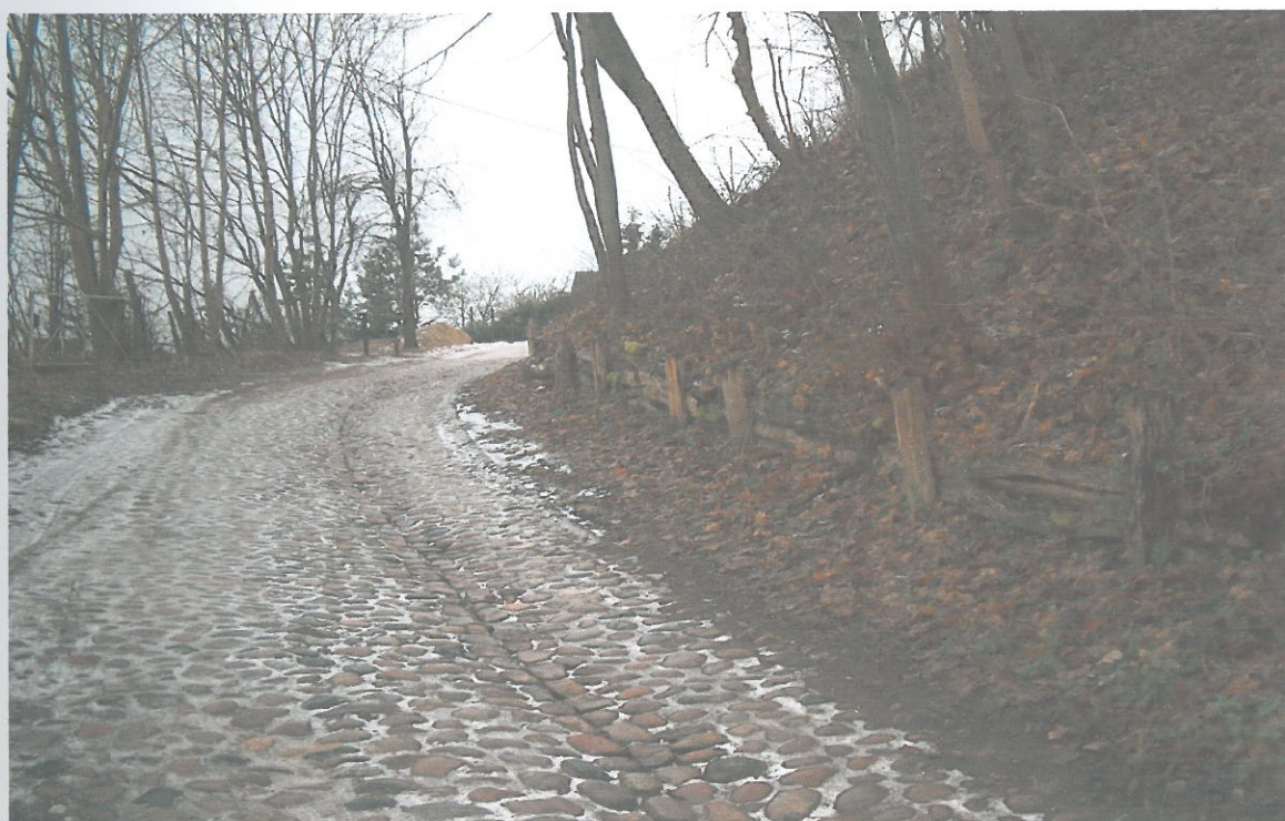
Foto 2. Widok na skarpe cz. B: zadrzewienia i krzewy umacniające skarpe. U podstawy widoczne stare drewniane umocnienia skarpy.
