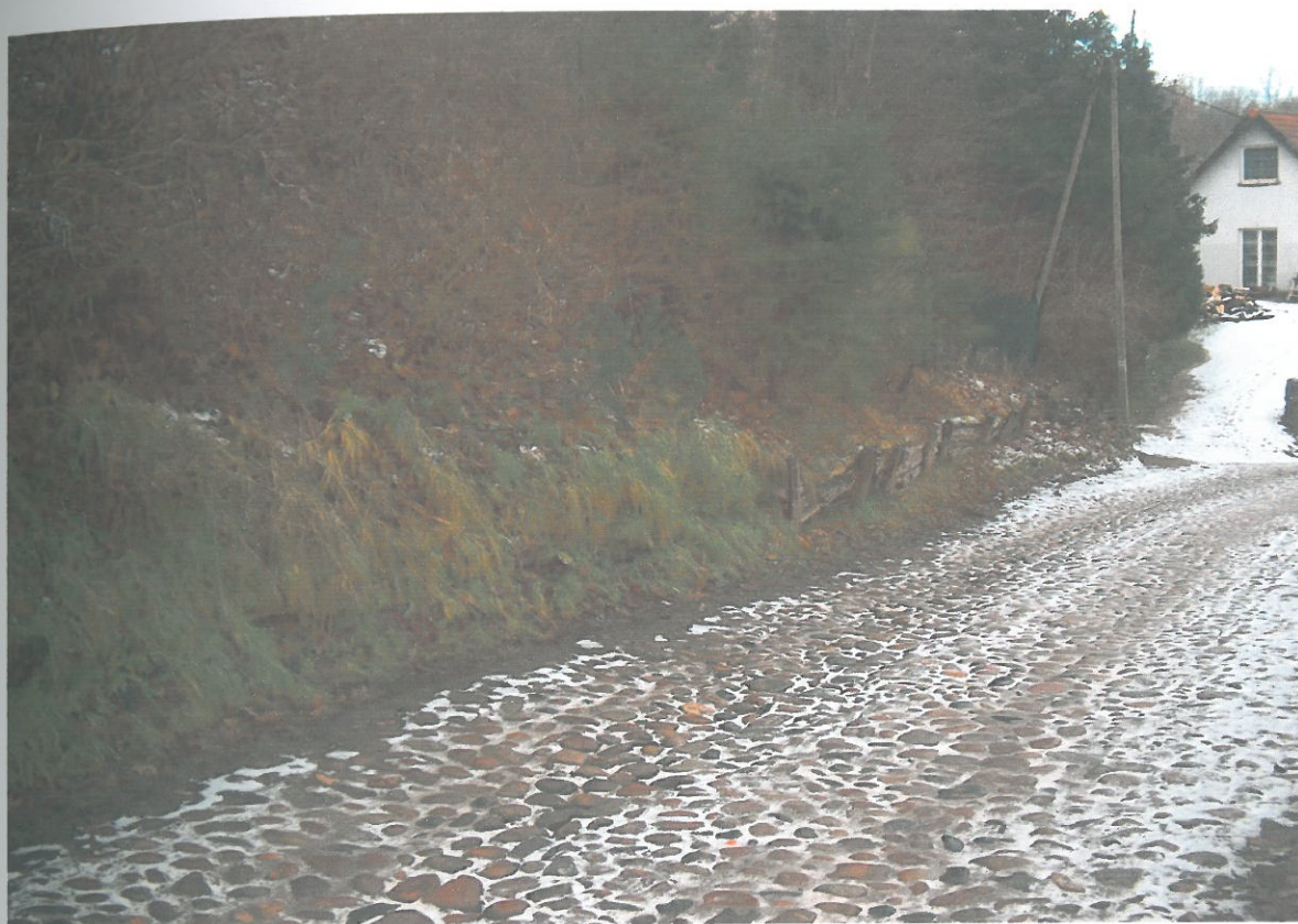
Foto. 3 Widok na skarpe w miejscu o najwyższym przewyższeniu ok. 17,5 m.
