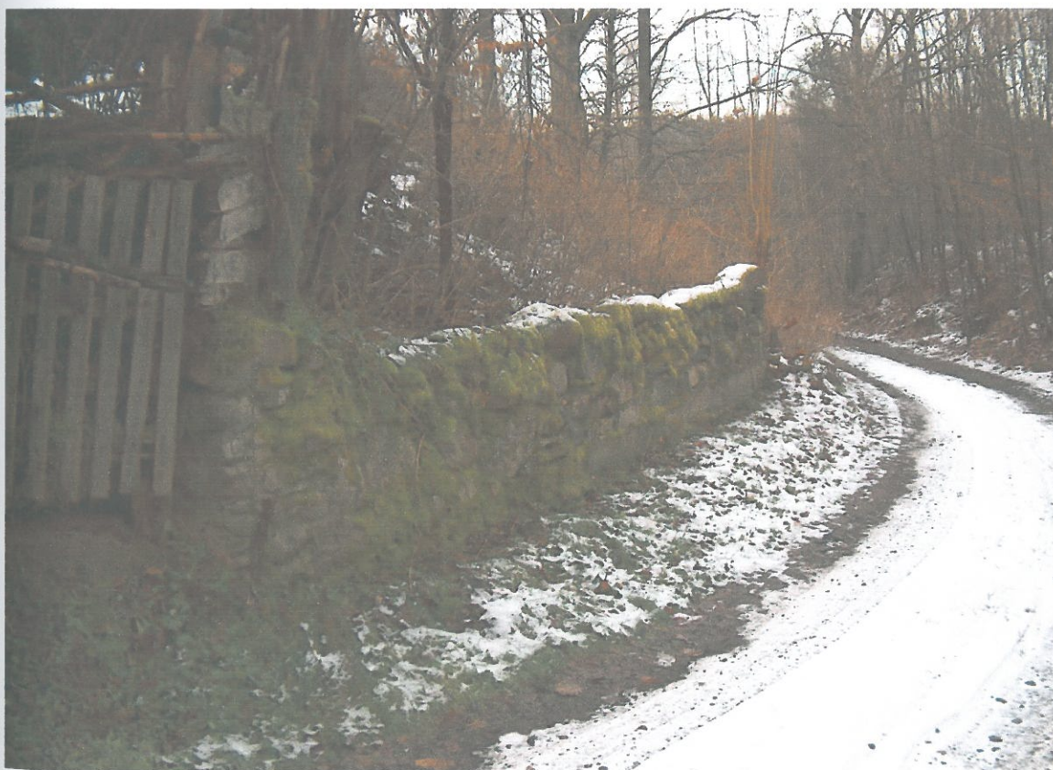
Foto 16. Dalszy ciąg istniejącego muru oporowego.
