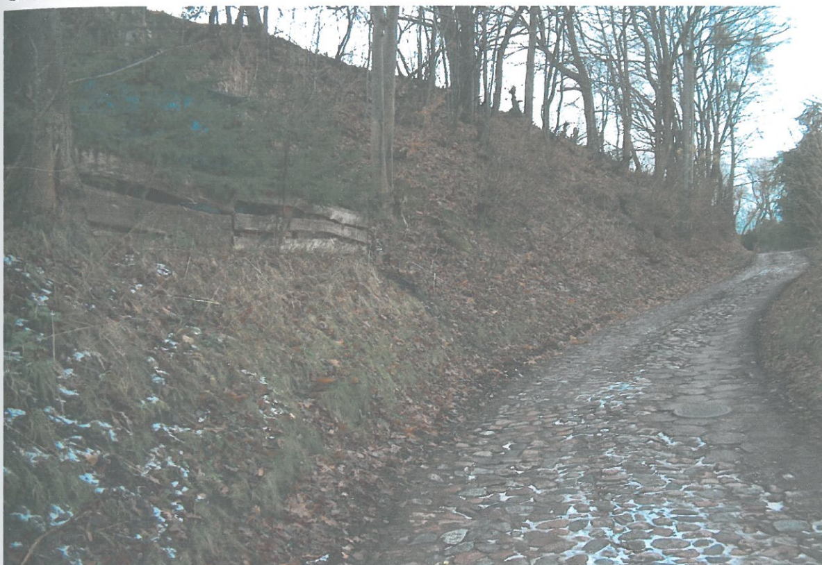
Foto 9. Widok ogólny. Stan zadrzewienia. Widoczna studzienka kanalizacyjna.
