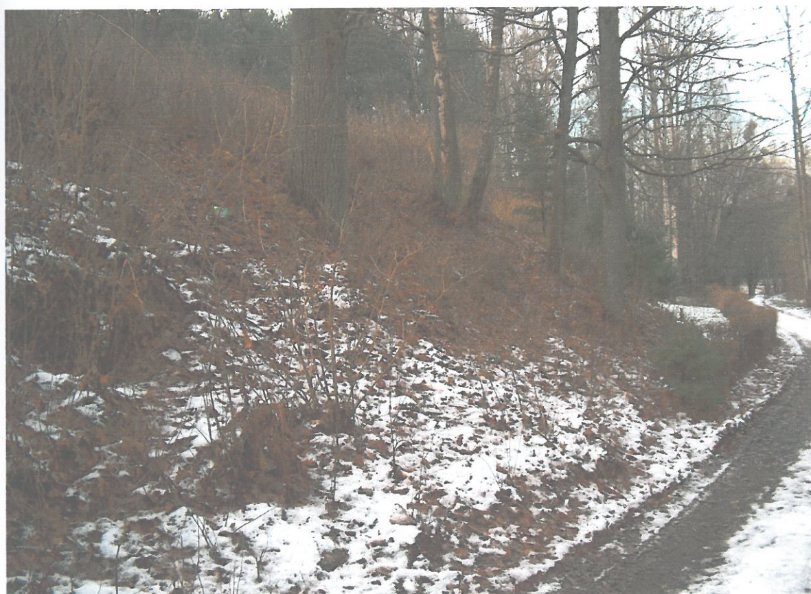
Foto 18. Stabilna skarpa z drzewostanem. Obok bez drzew widoczne przemieszczenia.
