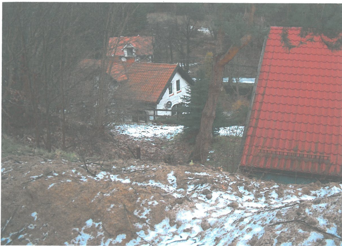
Foto 21. Widok na układ skarp powstały po podziale na tarasy użytkowe.
