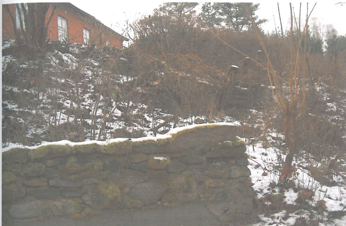
Foto 15. Fragment istniejącego muru oporowego
