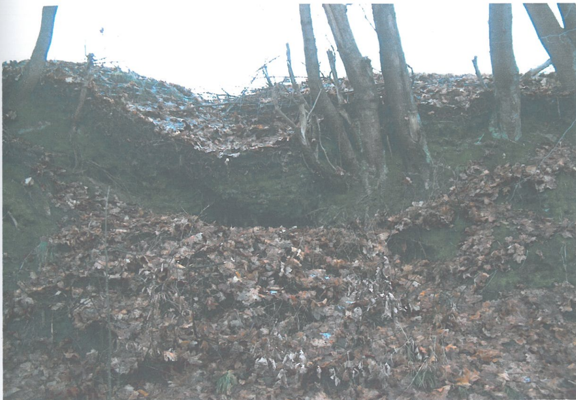
Foto 13. Szkody wyrządzone przez płynące wody powierzchniowe.
