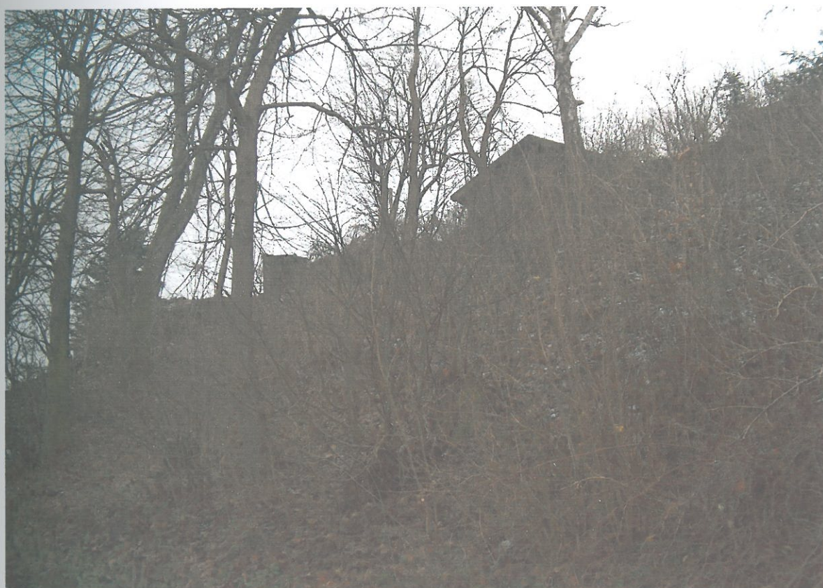
Foto 4. Widok na płaszczyznę i koronę skarpy: drzewostan oraz zakrzaczenia. W dali widoczna zabudowana krawędzi skarpy.
