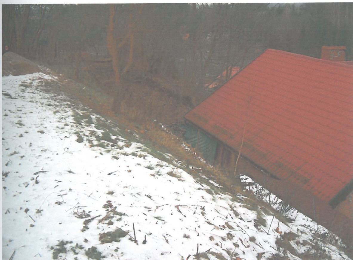
Foto 8. Skarpa po drugiej stronie drogi.
