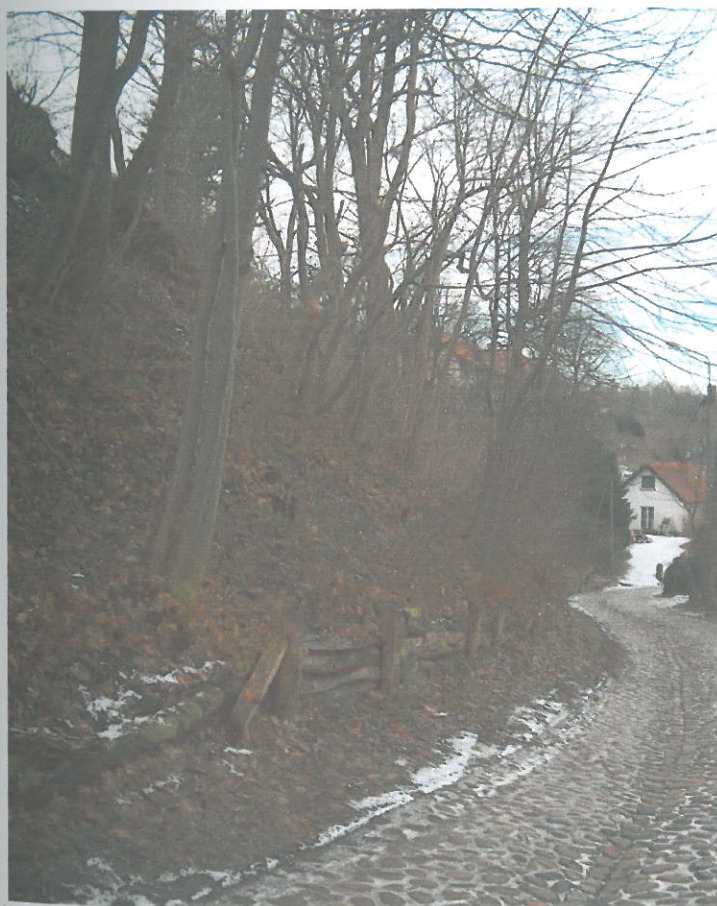
Foto 6. Widok ogólny skarpy. Niestateczna skarpa odsłania korzenie drzewa.
