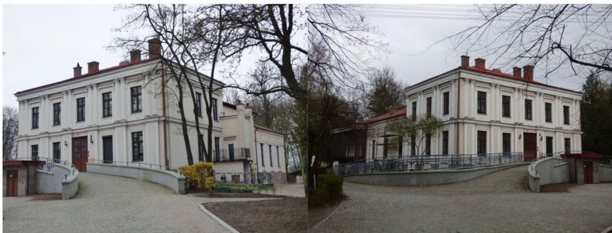
Fot. 9. Rokocin. Dwór (źródło - Gminna Ewidencja Zabytków).
