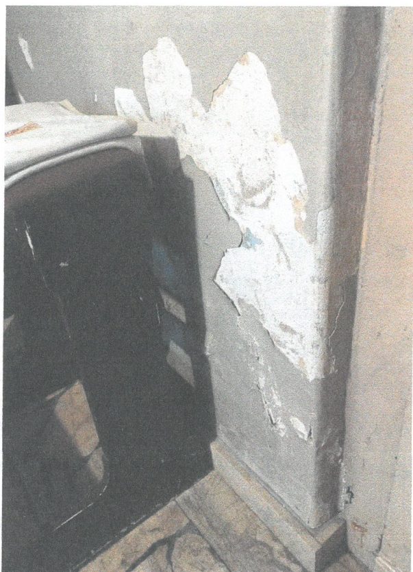
Fot. 5 i 6. Przykłady zniszczeń powłok malarskich i tynków wywołanych zawilgoceniem
