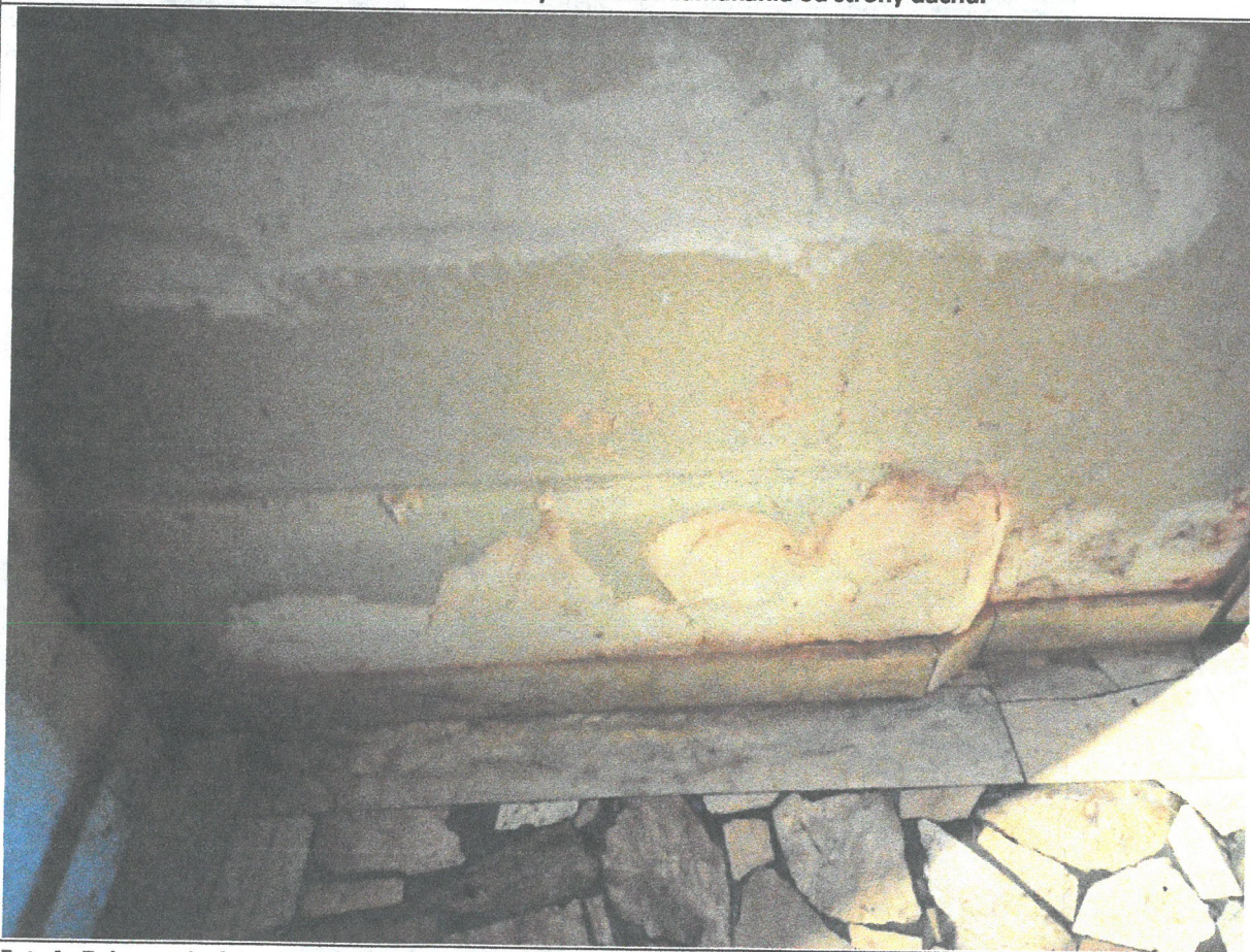
Fot. 4. Zniszczenie ściany w przyziemiu i uzupełnienie bruzdy na instalację.
