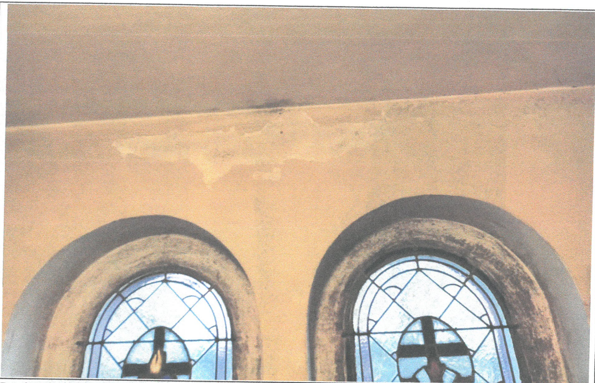
Fot. 3. Zakrystia wschodnia – zniszczenia ściany na skutek zamakania od strony dachu.
