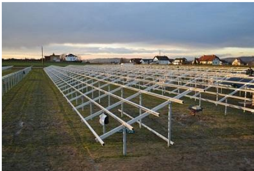
Fot. 18. Konstrukcje wsporcze ogniw fotowoltaicznych ( http://gramwzielone.pl/ )
