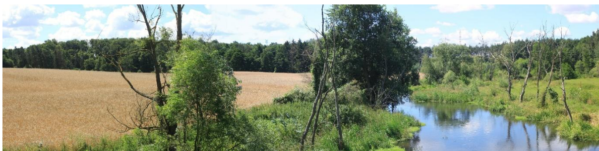
Fot. 6. Wierzycyca w północnej części obszaru projektu „Planu ...” - widok z mostu na północ od Klonówki w kierunku południowo-zachodnim
