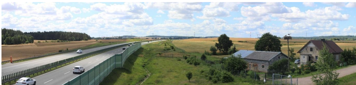
Fot. 4. Otoczenie autostrady A1 - widok w kierunku południowym z mostu na wschód od Klonówki, po prawej gniazdo bociana białego.
