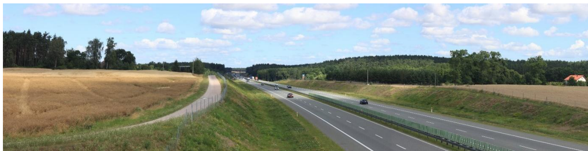
Fot. 3. Otoczenie autostrady A1 - widok w kierunku północnym z mostu na wschód od Klonówki
