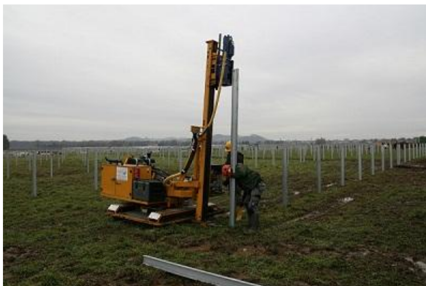
Fot. 17. Montaż konstrukcji wsporczych ogniw fotowoltaicznych ( http://gramwzielone.pl/ )
