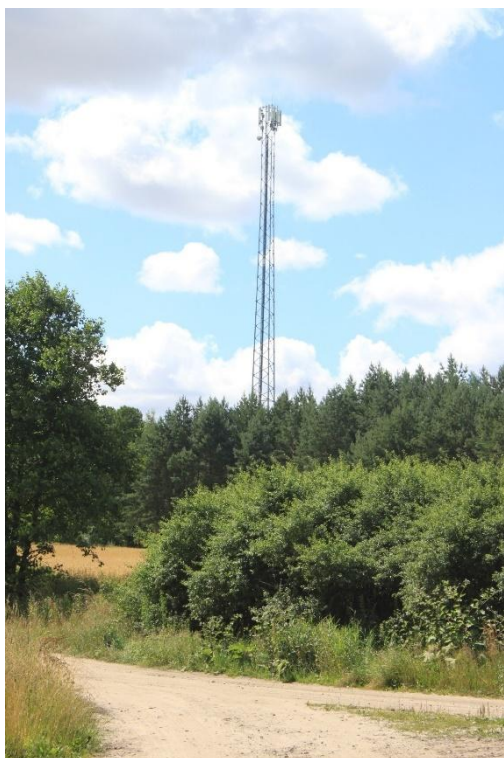
Fot. 13. Stacja bazowa telefonii komórkowej we wschodniej części obszaru projektu „Planu ...”
