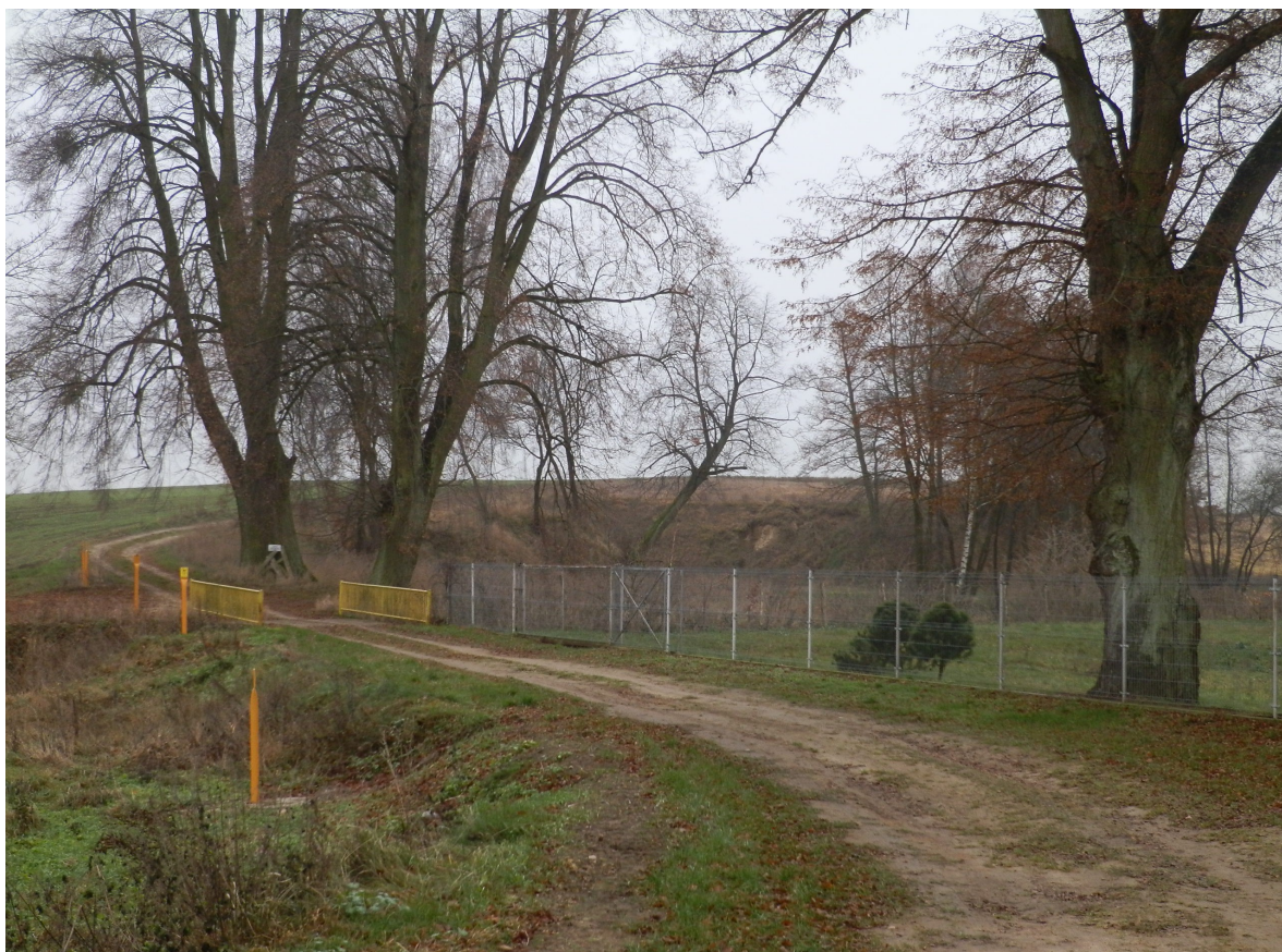
Fot.2. Widok na północny kraniec obrębu, teren zieleni przy ujściu cieku do rzeki Piesienicy Fot. K. Łukowicz
