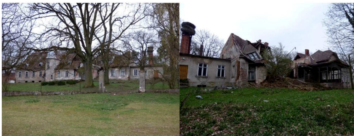
Fot. 8. Owidz. Dwór (źródło - Gminna Ewidencja Zabytków).
