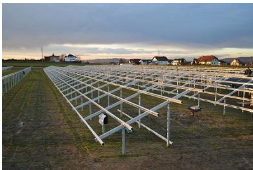
Fot. 2. Konstrukcje wsporcze ogniw fotowoltaicznych ( http://gramwzielone.pl/ )
