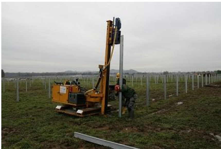
Fot. 1. Montaż konstrukcji wsporczych ogniw fotowoltaicznych ( http://gramwzielone.pl/ )
