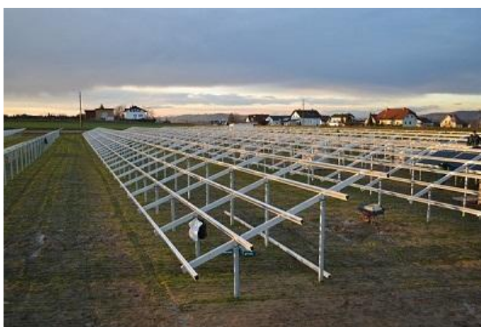
Fot. 2. Konstrukcje wsporcze ogniw fotowoltaicznych ( http://gramwzielone.pl/ )
