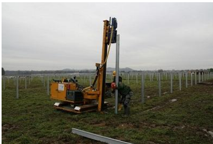
Fot. 1. Montaż konstrukcji wsporczych ogniw fotowoltaicznych ( http://gramwzielone.pl/ )
