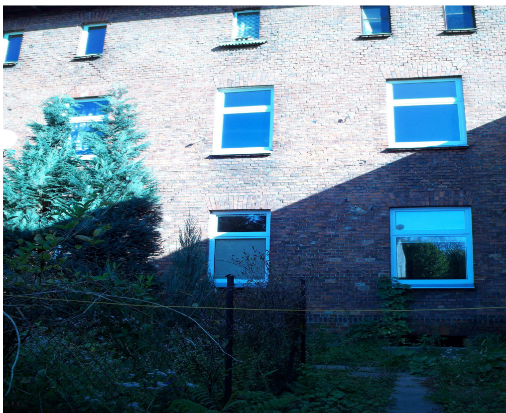
Ściana zewnętrzna nośna, widoczne nadproża murowane w formie łuków płaskich
