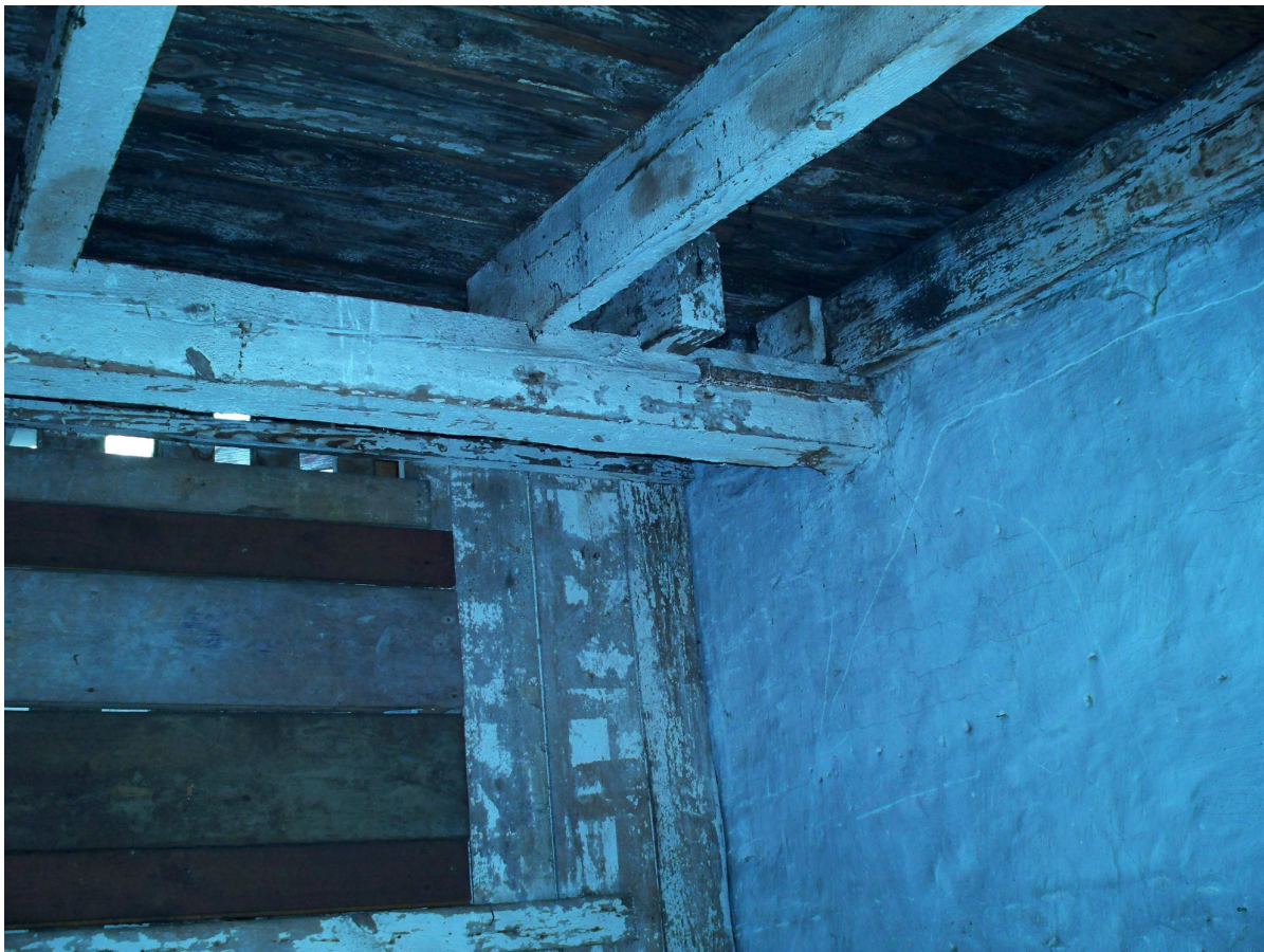
Fragment konstrukcji stropodachu – widoczne ślady negatywnego oddziaływania czynników atmosferycznych i biologicznych na konstrukcję
