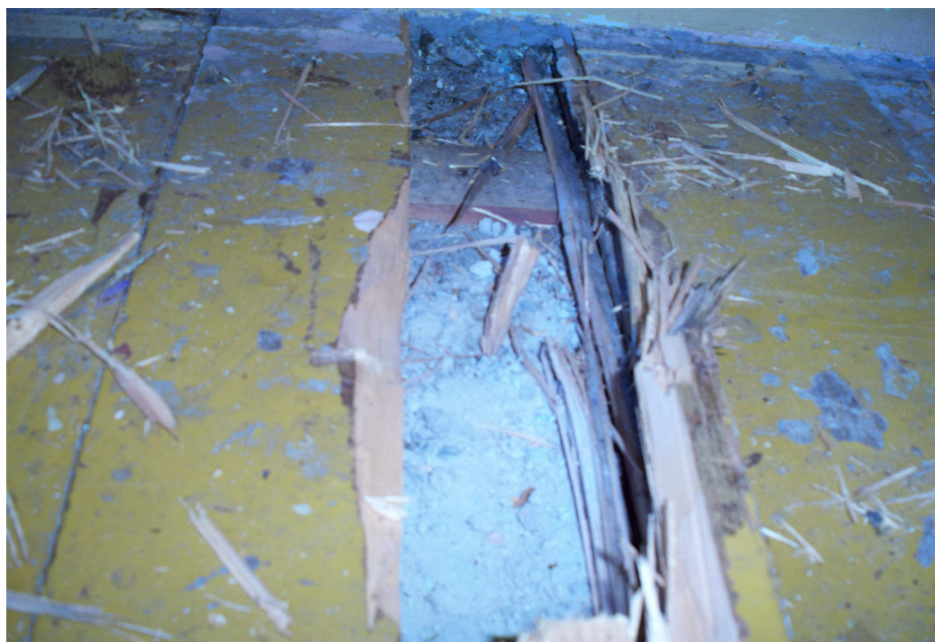
Fragment konstrukcji stropu drewnianego – widoczne deskowanie oraz wypełnienie z piasku
