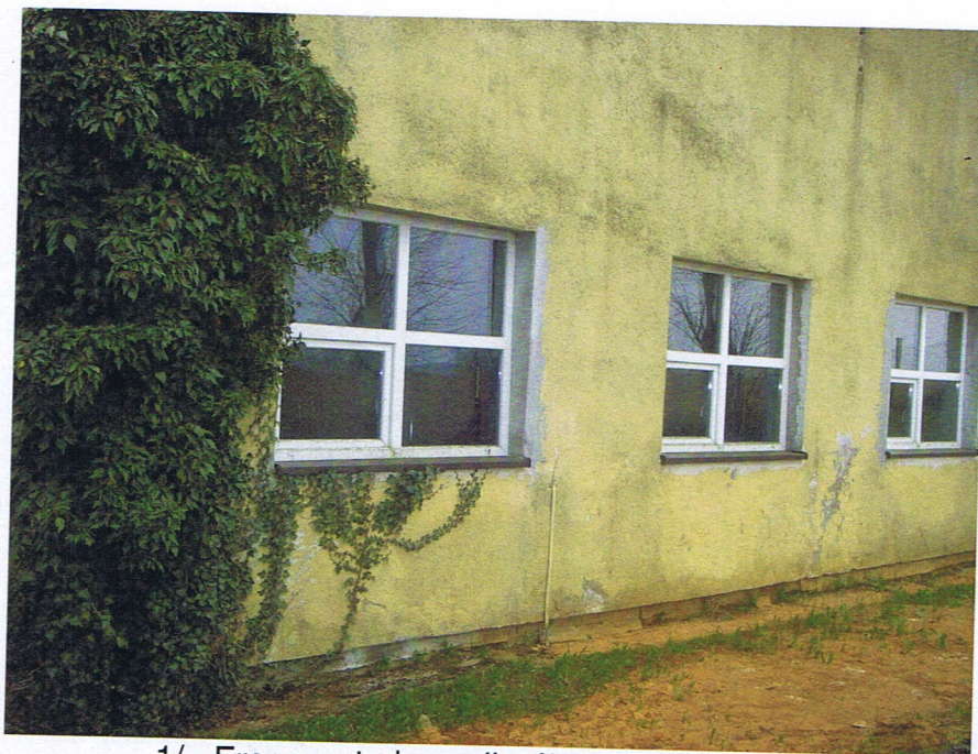
1/ Fragment elewacji północnozachodniej
