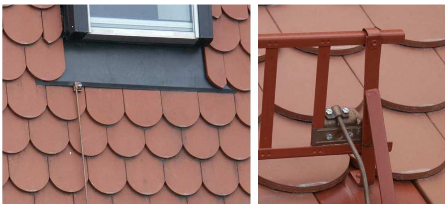
Rys.3. Łączenie metalowych ram okiennych z przewodami instalacji piorunochronnej.
