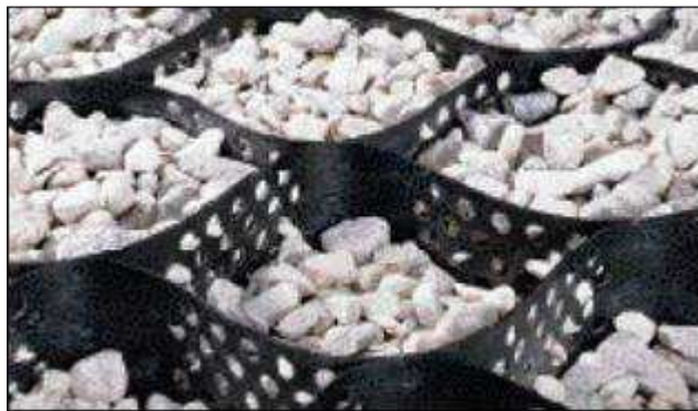
Rys. 8. Zasypywanie kruszywem komórek geosiatki za pomocą ładowarki
