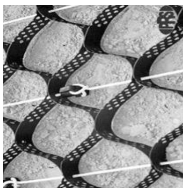
Rys. 6. Linki poliestrowe wzmacniające konstrukcję geosiatki komórkowej
