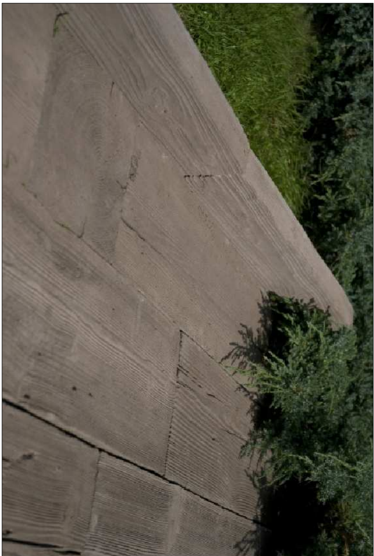
Przykład nawierzchni z deski betonowej
