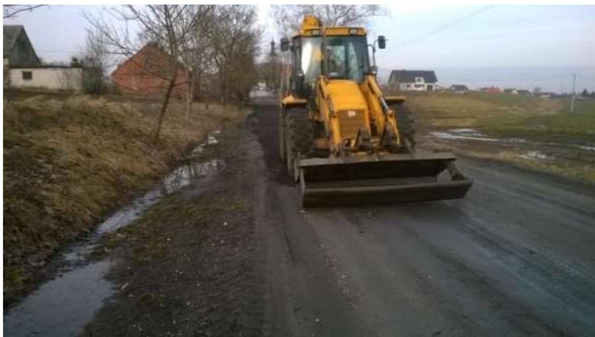
Fot. Równanie drogi i rów przed renowacją.
