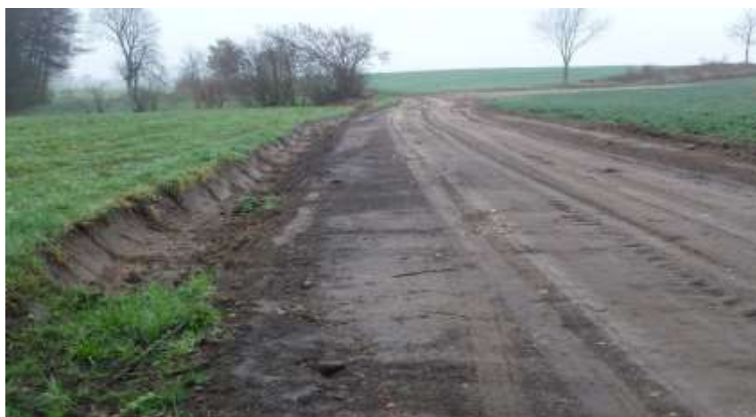
Fot. Droga po modernizacji. Grunt z wykonania rowu został odwieziony sprzętem mieszkańców. .
