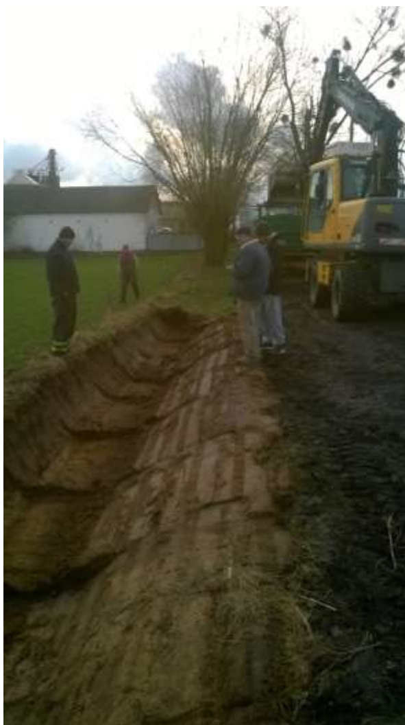
Fot. Wykonywanie odbudowy rowu na
