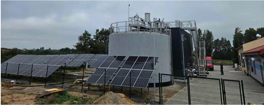
Rys. 34 Oczyszczalnia ścieków w Gminie Skulsk po przeprowadzonej modernizacji
