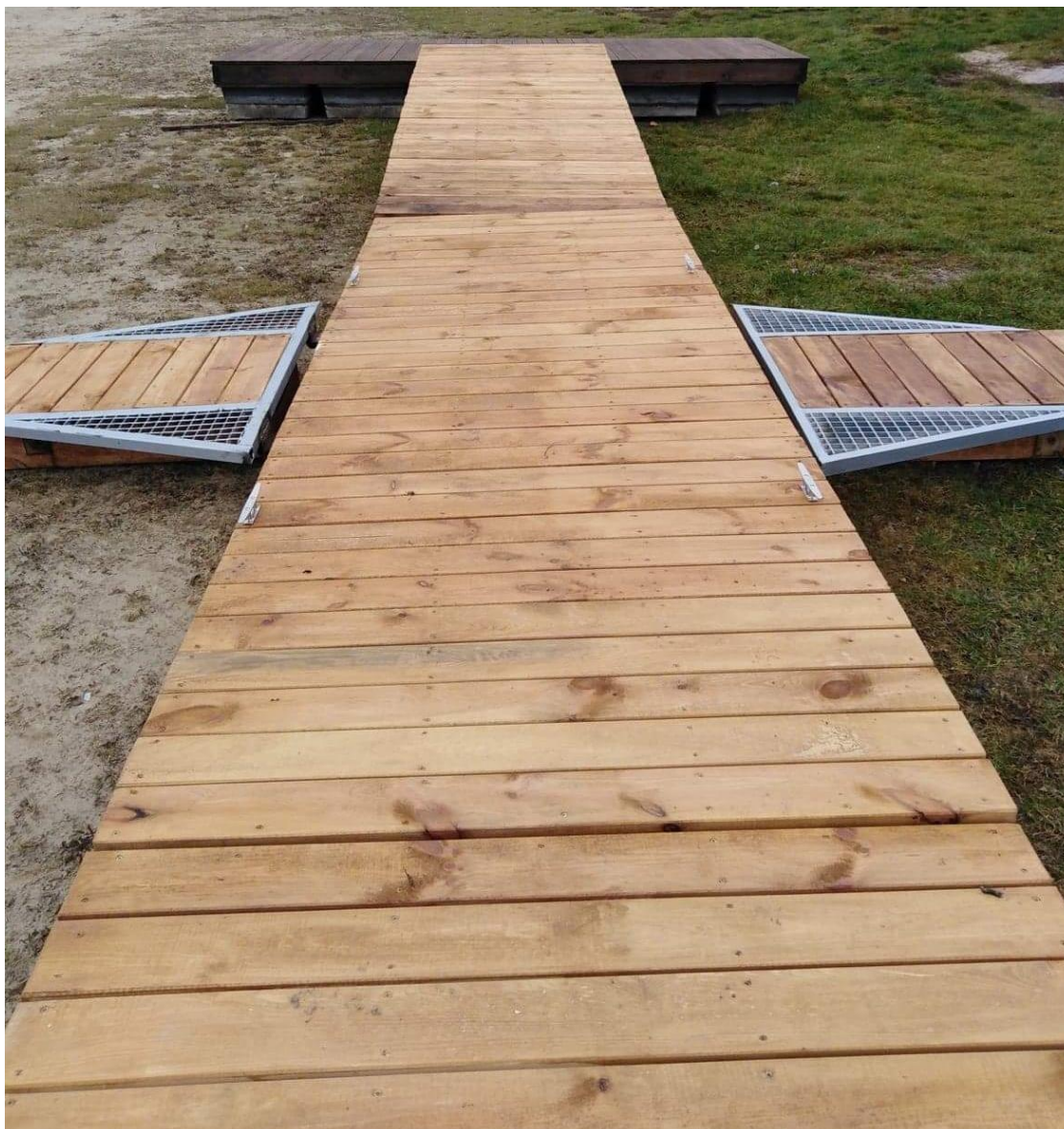
Przystosowanie pomostu do funkcji cumowniczej nad j. Gopło w Łuszczewie.
