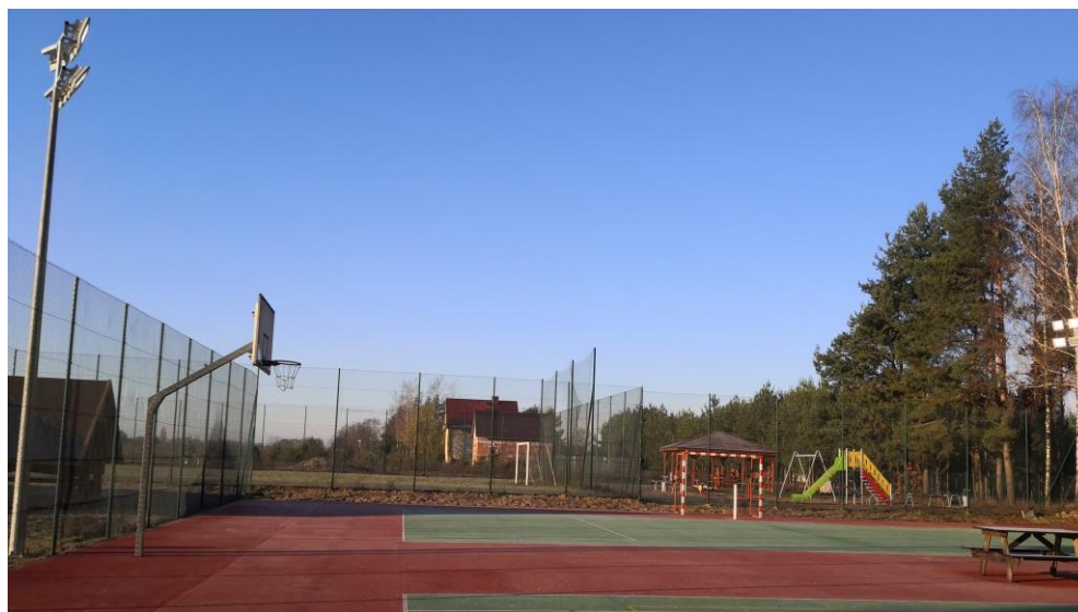
Montaż oświetlenia boiska wielofunkcyjnego na osiedlu Mniszki.
