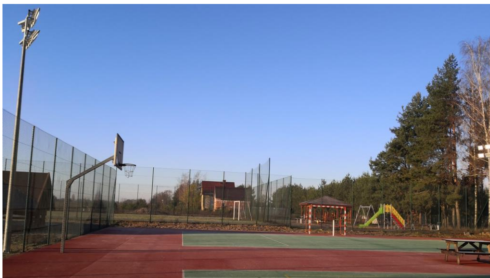
Montaż oświetlenia boiska wielofunkcyjnego na osiedlu Mniszki.
