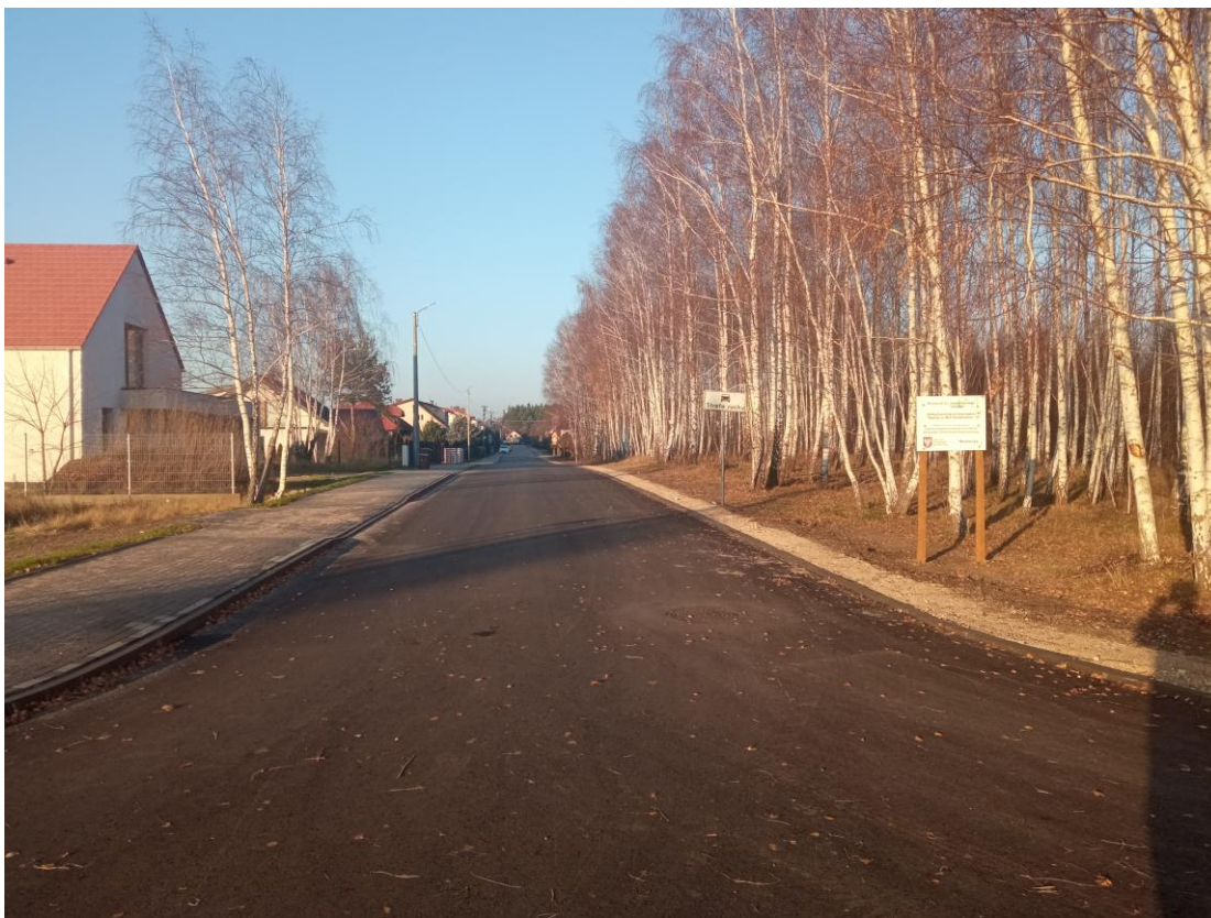
Zdjęcie 3 - Rozbudowa drogi w miejscowości Rząśnik ul. Marii Konopnickiej
