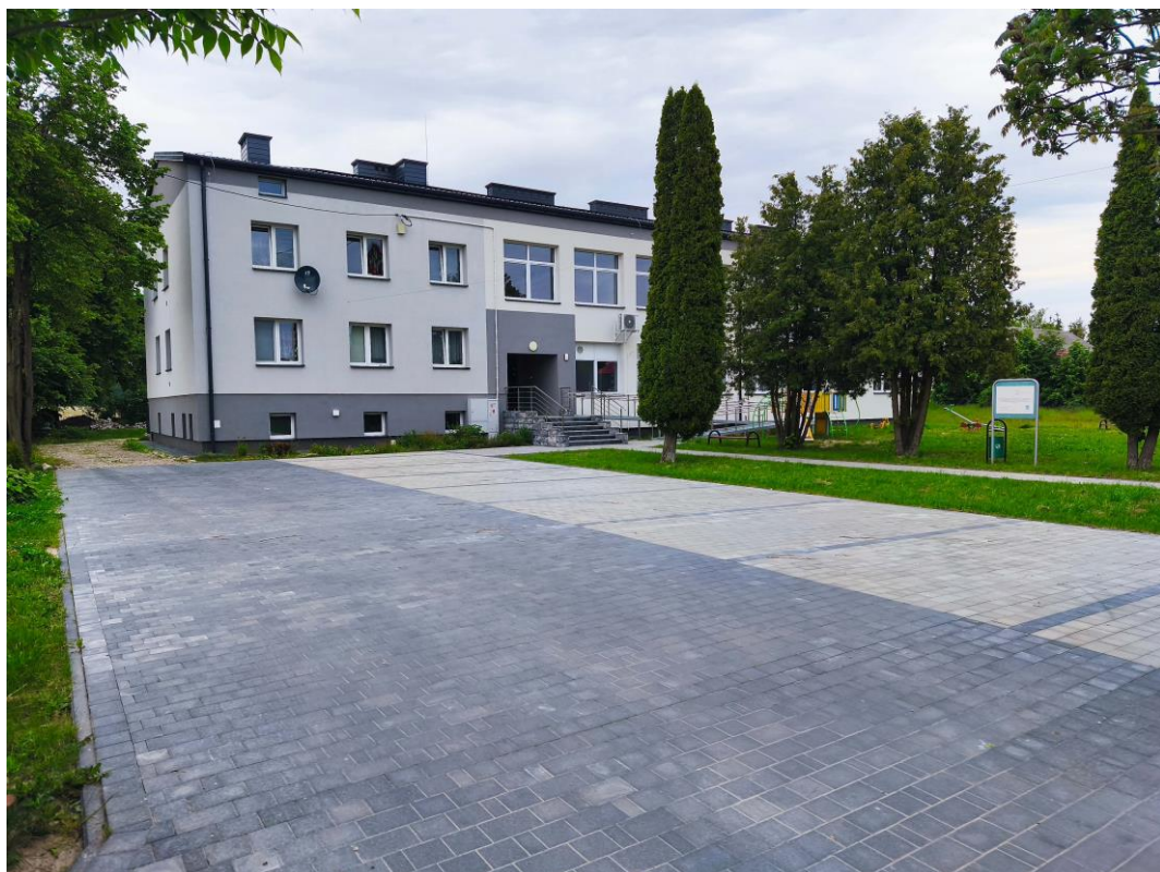
Zdjęcie 7 - Termomodernizacja budynku świetlicy wiejskiej w Nowych Wielątkach
