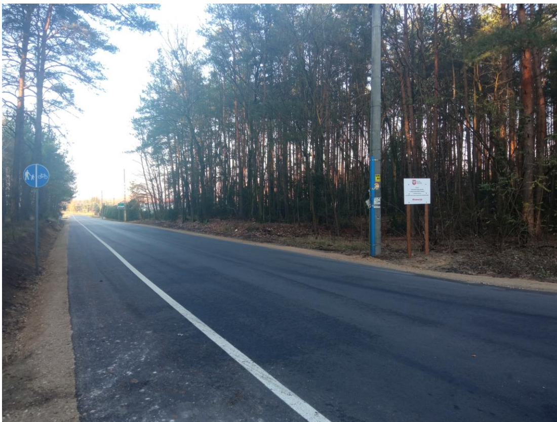
Zdjęcie 4 - Rozbudowa drogi w miejscowości Wólka Przekory
