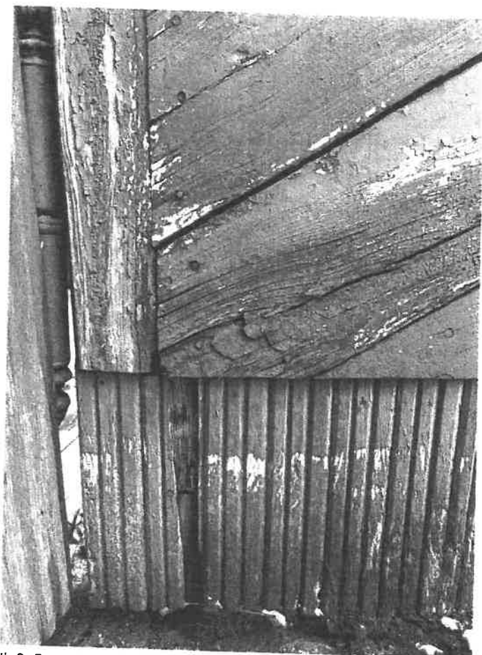
Il. 9. Fragment lewego skrzydła od strony zewnętrznej. Zdegradowana warstwa malarska Ubytki drewna, pęknięcia i obtłamanie (fot. K. C-J).
