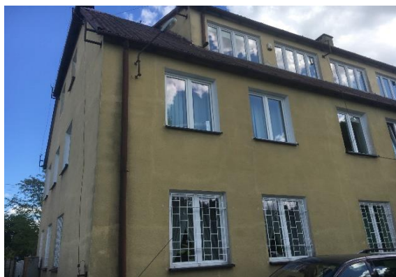
Widok elewacji północnej i zachodniej nowszej części budynku
