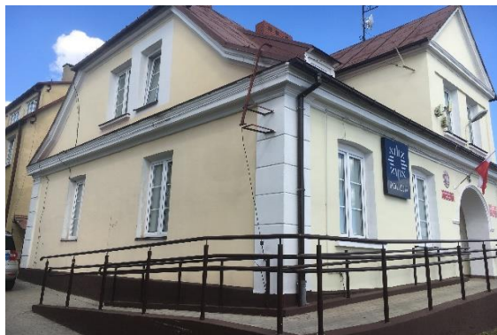
Widok elewacji zachodniej i południowej starszej części budynku
