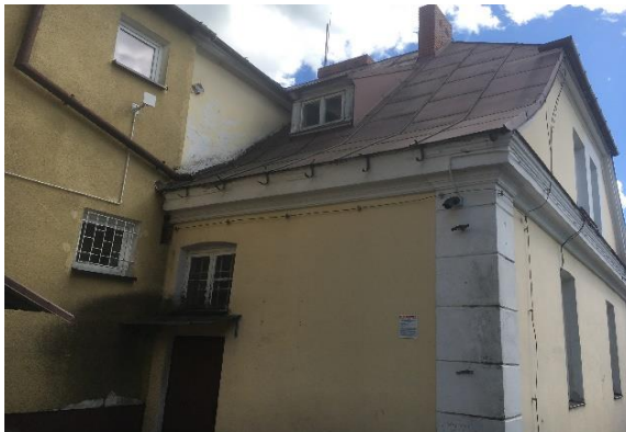
Widok fragmentu elewacji łącznika (zachód) oraz elewacji północnej starszej części budynku
