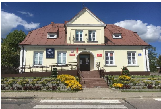
Widok elewacji południowej starszej części budynku
