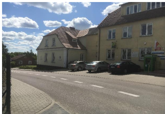
Widok elewacji wschodniej
