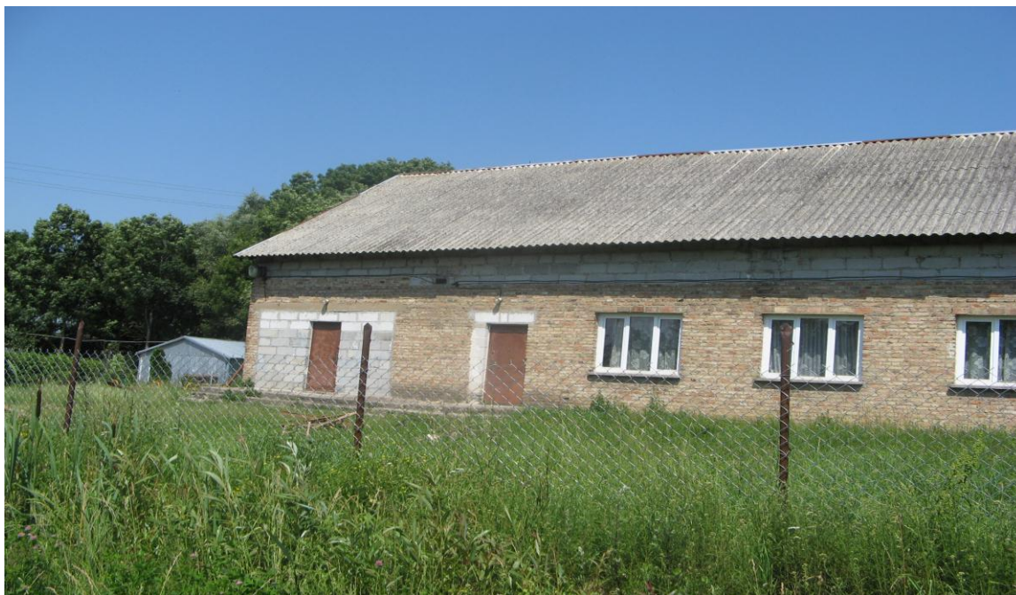
Fot.8: Budynek świetlicy wiejskiej w Lipie.
