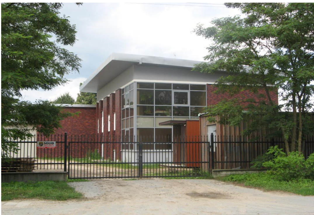
Fot.8: Nowy obiekt magazynowy w Pawłowie.
