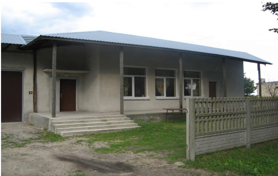
Fot.11: Budynek świetlicy wiejskiej w Pawłowie.
