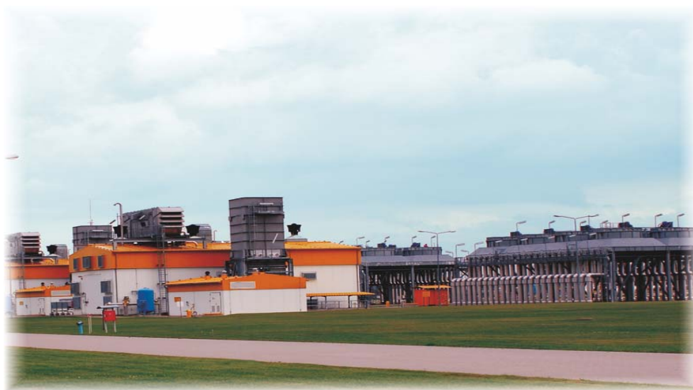
Fot. 4: Tłocznia gazu na gazociągu Jamał – Europa Zach. w Lekowie
