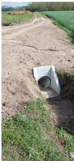
Przepust w m. Kątki
