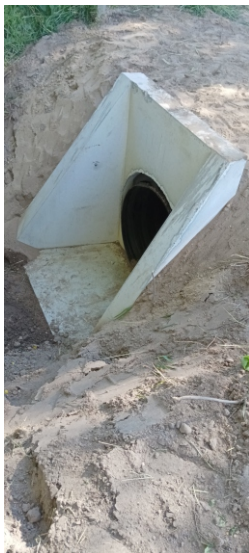
Przepust w m. Jarluty Małe
