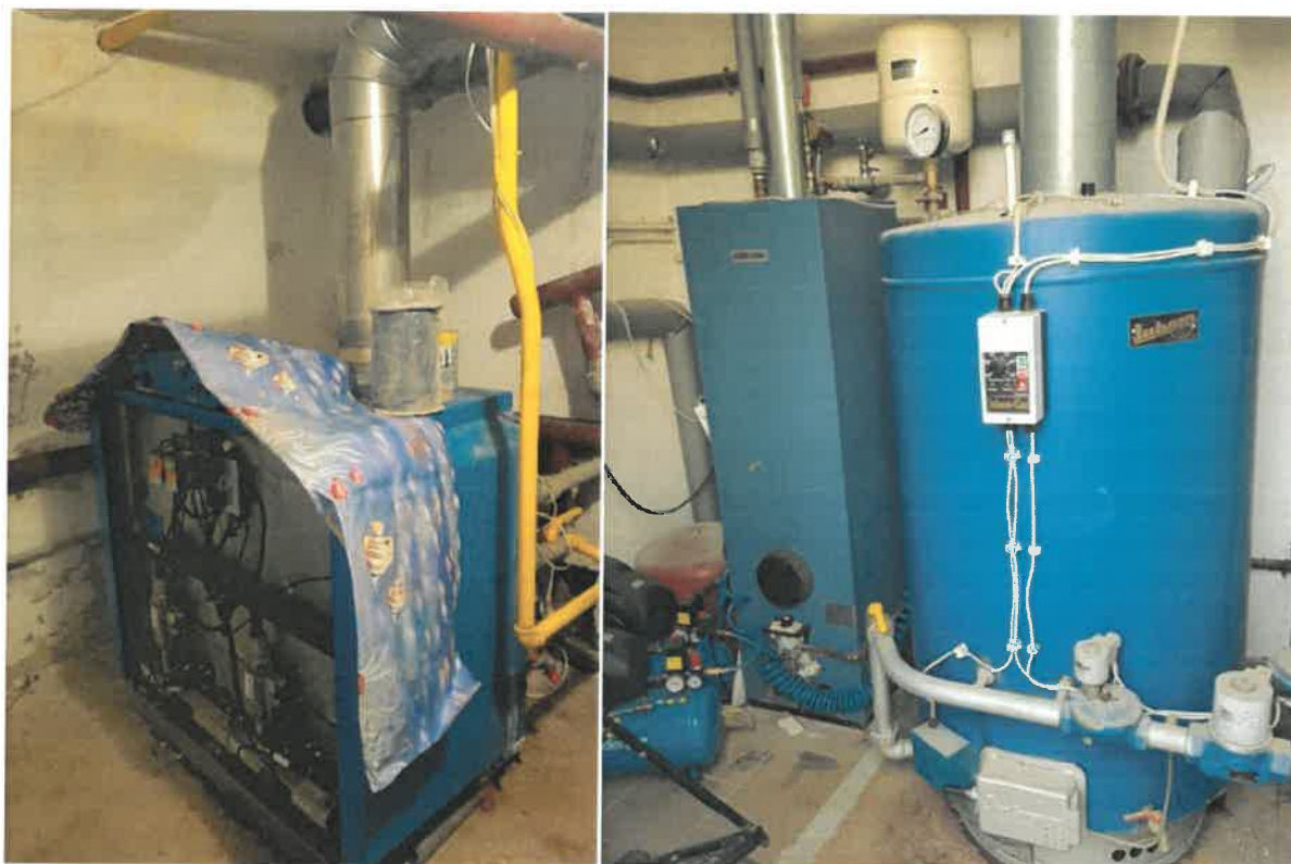
Rysunek 3. Istniejące kotły w kotłowni gazowej.
