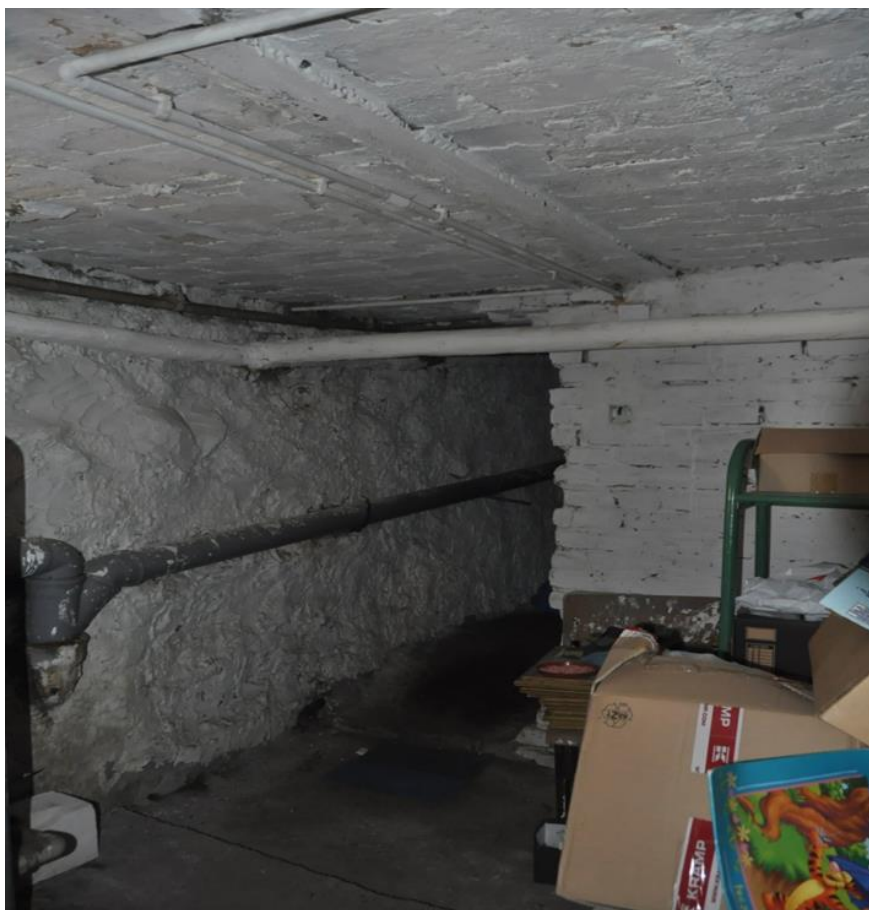
Fot. 1 Widok ściany zewnętrznej piwnic i stropu Kleina
