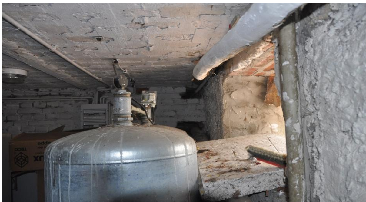
Fot. 2 Widok ściany zewnętrznej i stropu z otworami w ścianie wewnętrznej wykonanymi prawdopodobnie podczas prac instalacyjnych.
