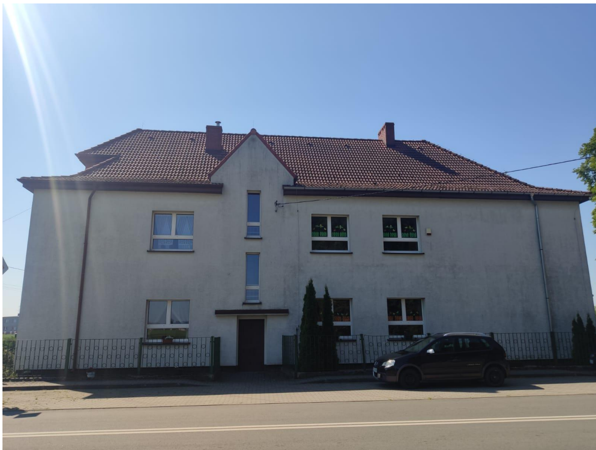
Fot.1 Ogólny widok budynku od frontu – ul. Lubliniecka.
