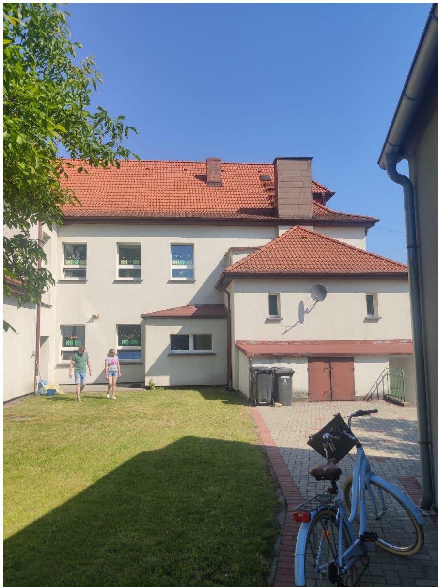
Fot.2 Ogólny widok w miejscu planowanego wejścia do przedszkola.
