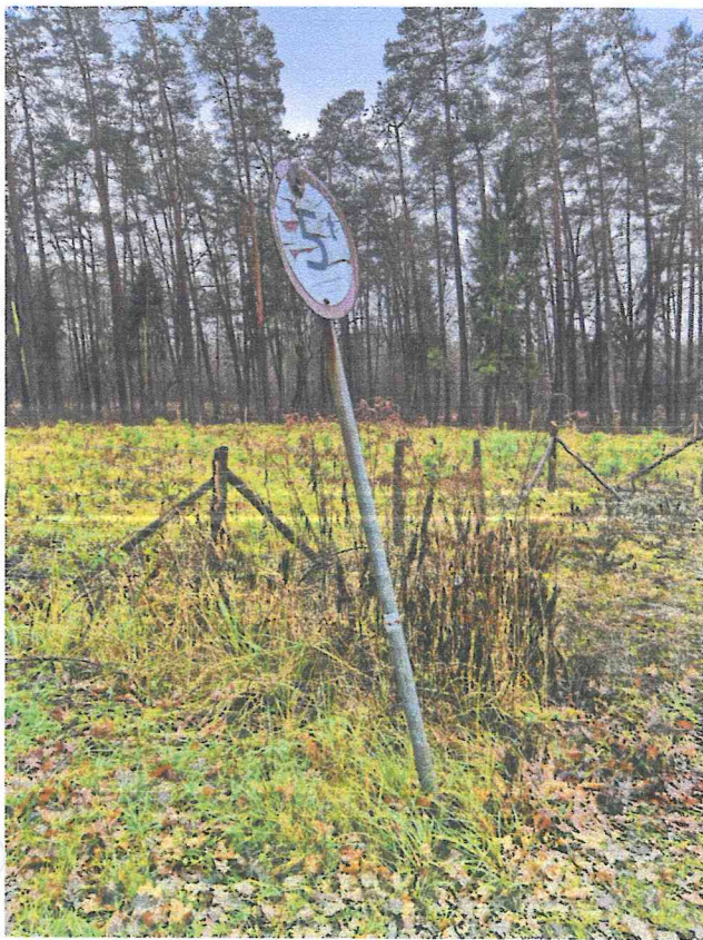
Znak B-18 "zakaz wjazdu pojazdów o rzeczywistej masie całkowitej ponad 5 t (skrzyżowanie ul. Szkolnej z drogą powiatową 2321 S) Znak jest wyraźnie zniszczony oraz nieczytelny.
