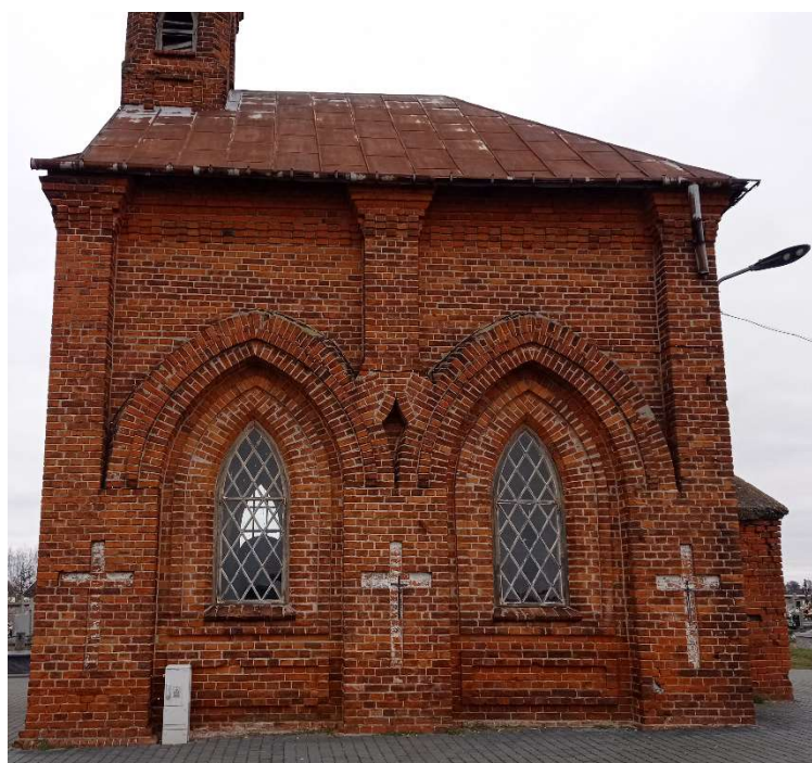
Zdjęcie nr 3. Zniszczone obróbki blacharskie kaplicy. Elewacja boczna (południowa).
