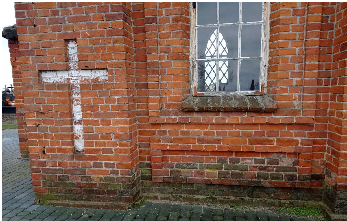
Zdjęcie nr 1. – Lokalne zazielenienie części powierzchni ścian.
