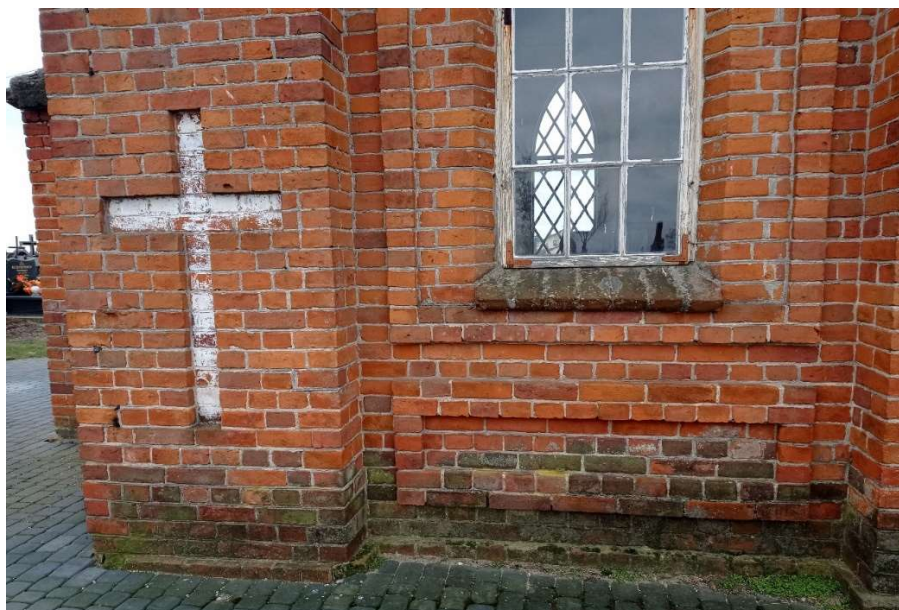
Zdjęcie nr 8. Zawilgocenie ścian przyziemia
