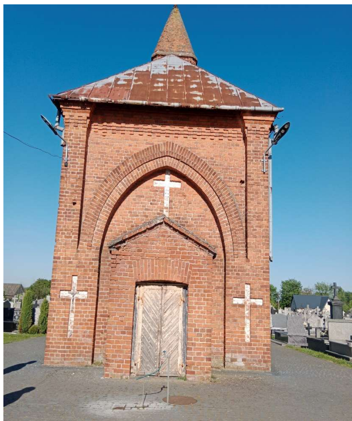
Zdjęcie nr 2. Zniszczone obróbki blacharskie kaplicy. Elewacja tylna (wschodnia).
