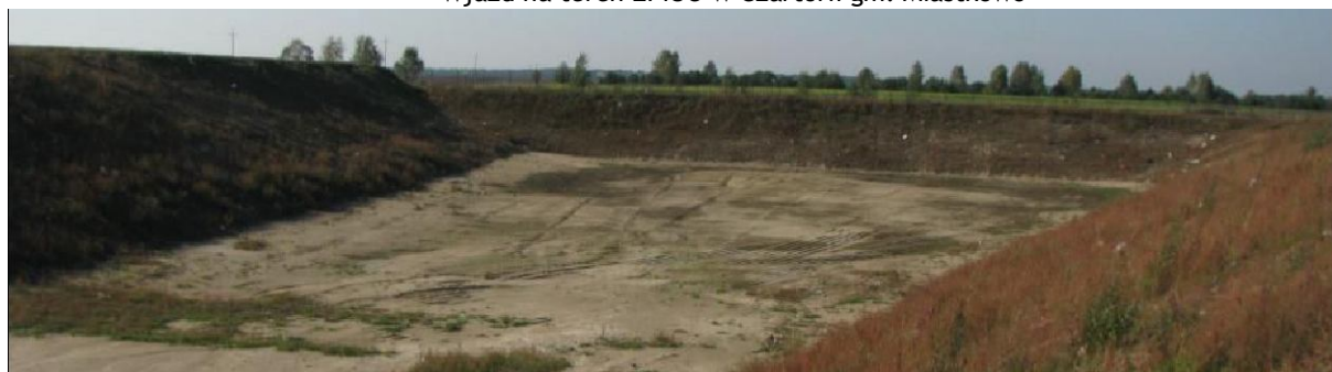
Kwatera odpadów azbestowych( w budowie)
