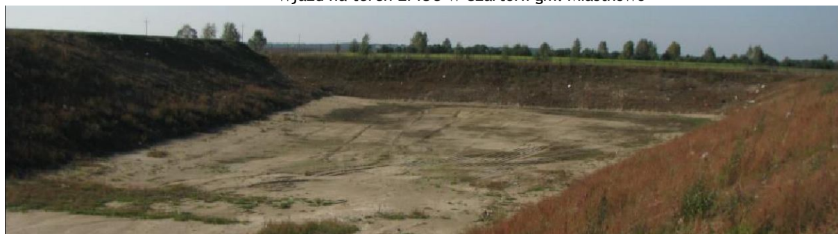
Kwatera odpadów azbestowych( w budowie)
