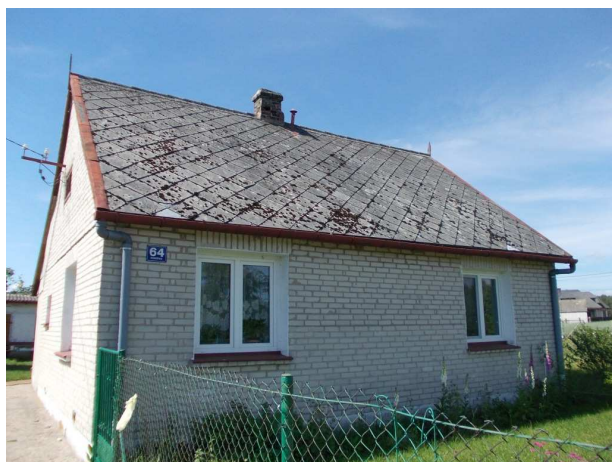
Ryc. 1. Płyty azbestowo-cementowe typu „karo” i płyty dachowe faliste występujące na terenie Gminy Ostrów Mazowiecka.
