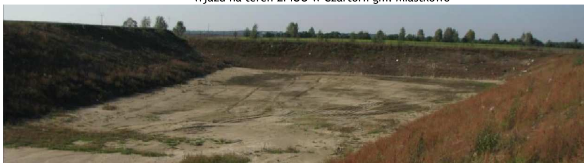
Kwatera odpadów azbestowych( w budowie)
