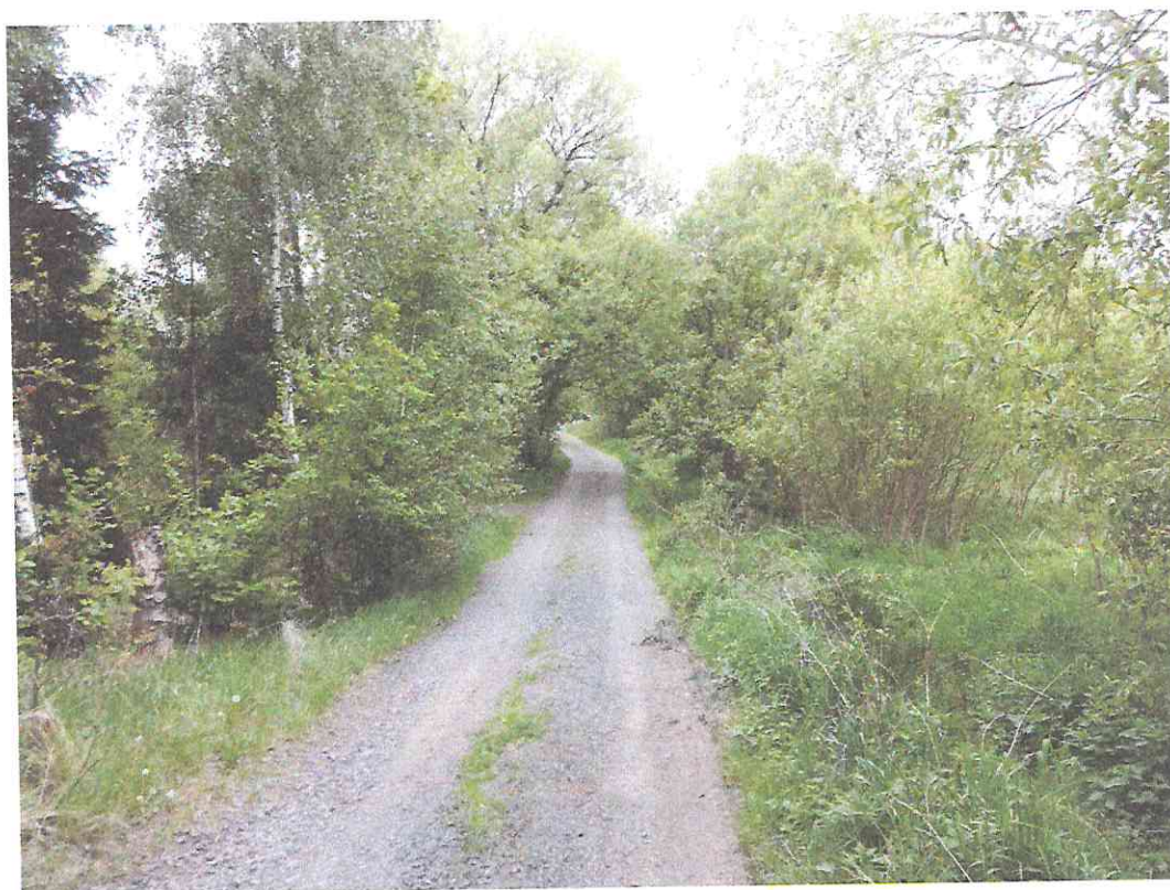
Widok w środkowej części drogi
