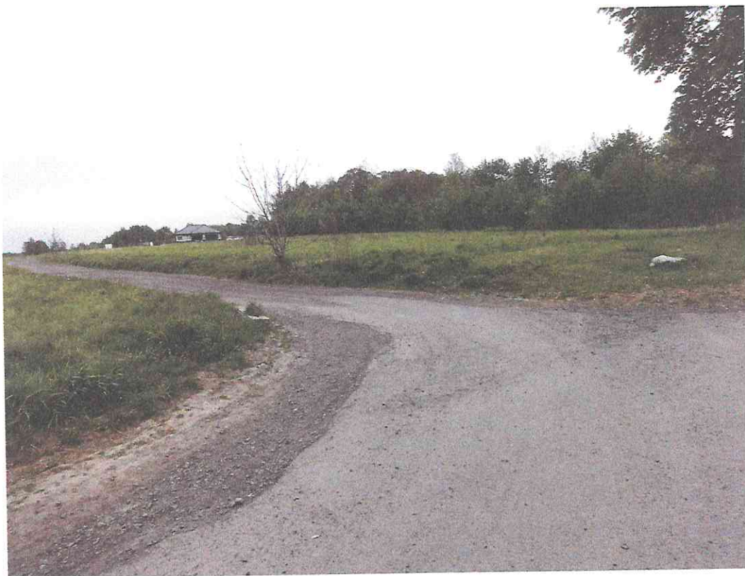
Początek drogi km 0+000
