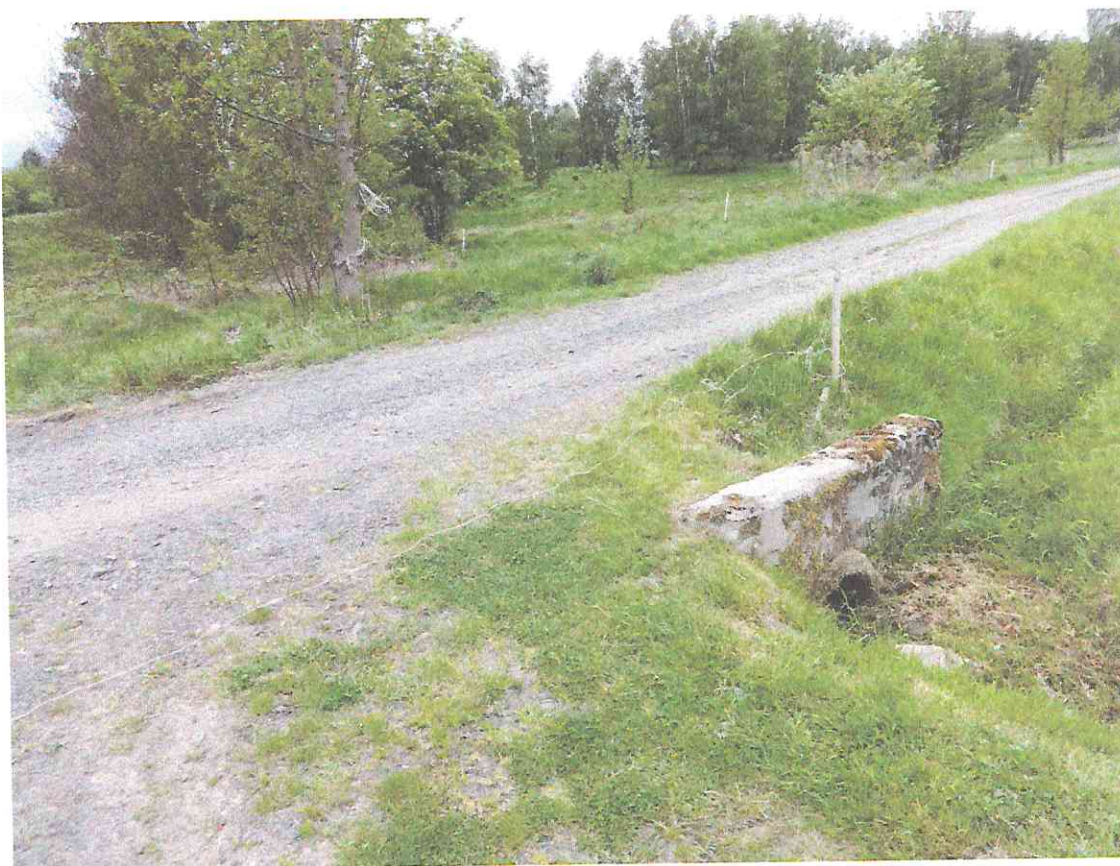
Przepust w km 0+685
