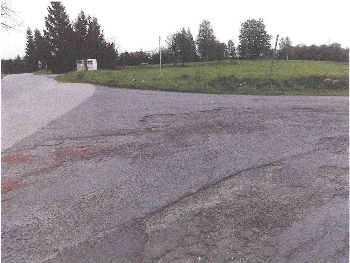
Km 0+420 włączenie do drogi 2513D.
