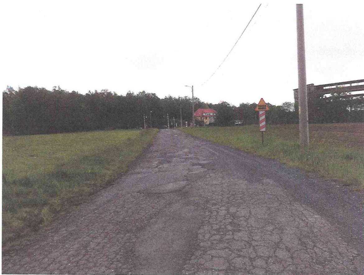
Widok na przejazd kolejowy w km 0+000 drogi
