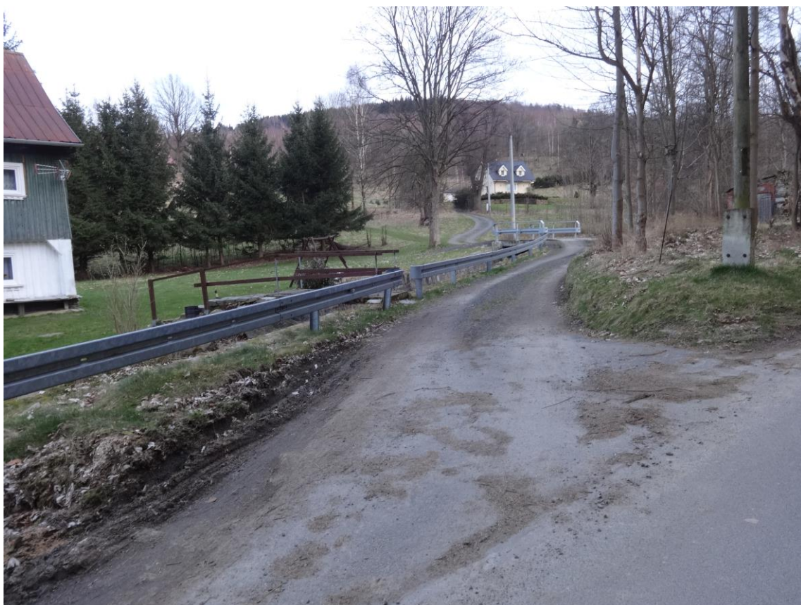
Droga w km 0+000 – włączenie do drogi gminnej nr 112717D
