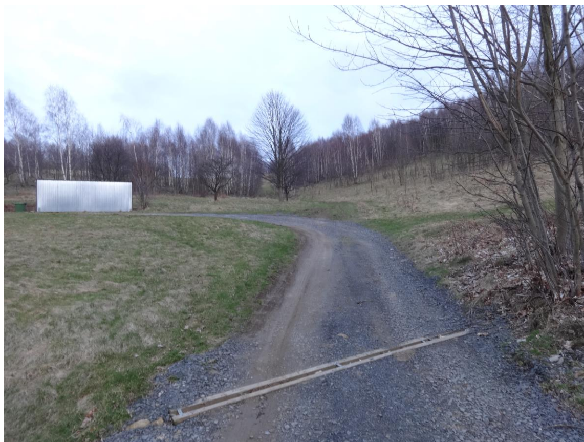
Widok na końcowy odcinek drogi km 0+200
