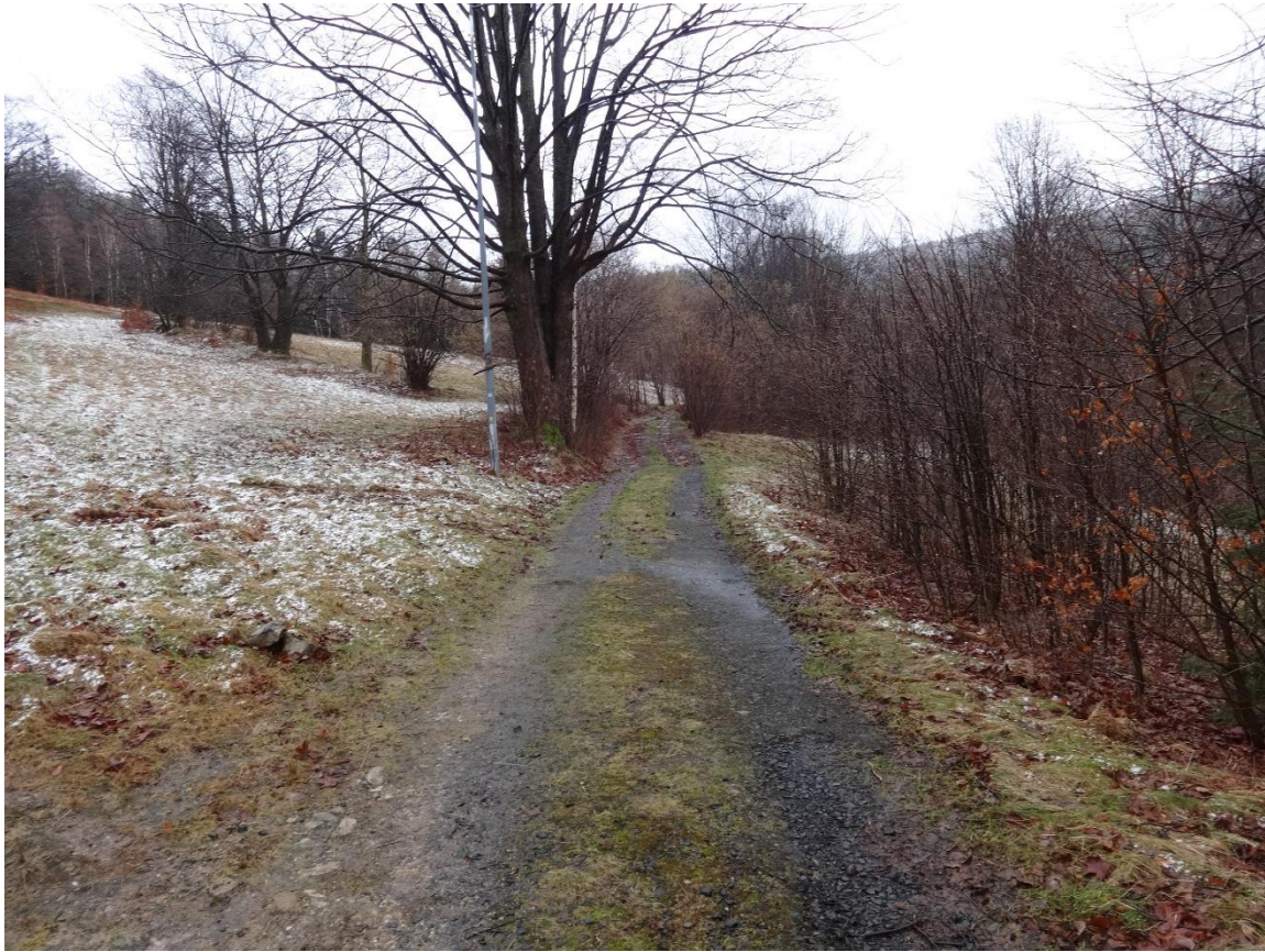
Widok na końcowy odcinek drogi w km 2+295. (0+625 dla robót)
