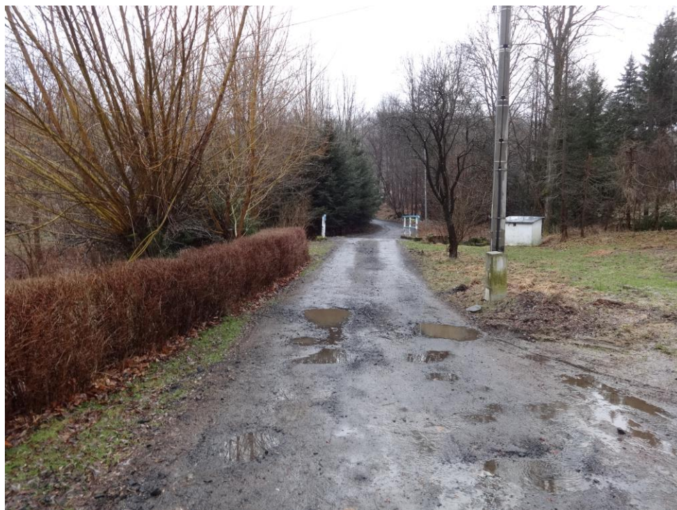
Początkowy odcinek remontowanej drogi 0+000( km 1+670 drogi)
