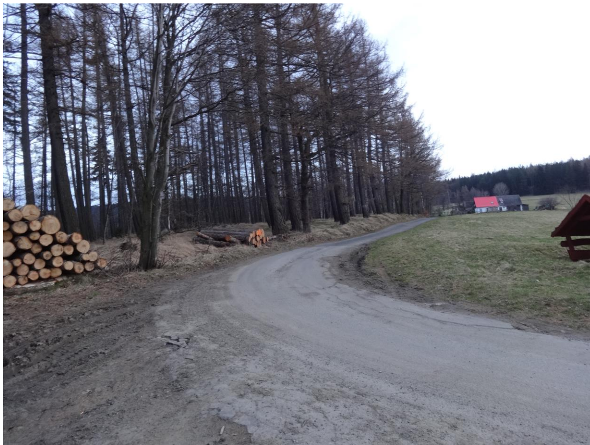
Widok drogi w końcowym odcinku nawierzchni bitumicznej 0+105km.
