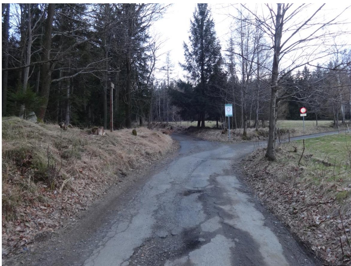
Widok drogi na końcowy odcinek w km 0+450 i początek drogi wewnętrznej 537.
