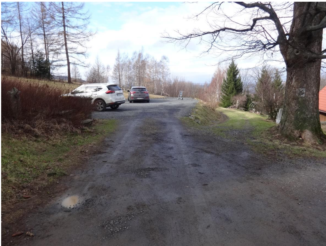
Końcowy odcinek drogi nr 537 na wysokości posesji 88 i 90.
