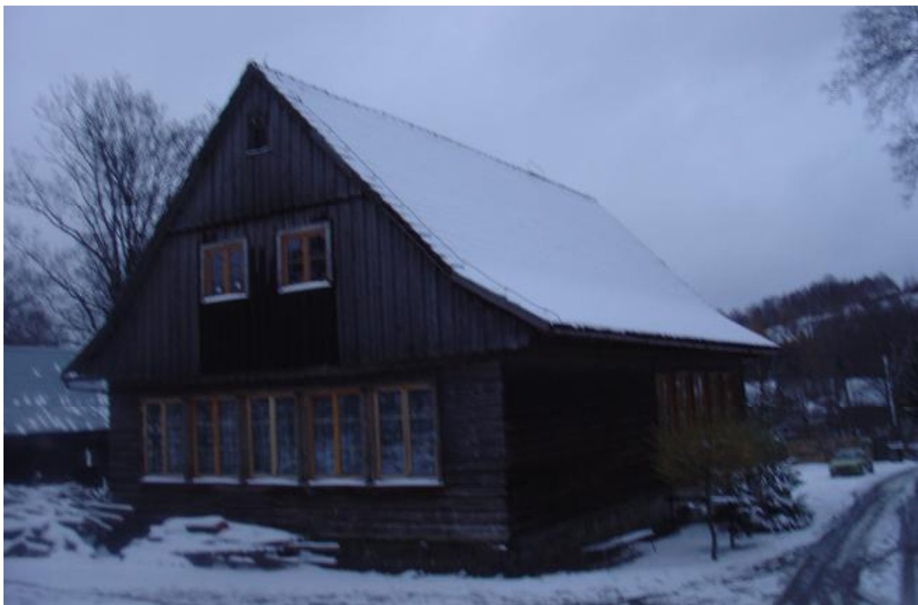
Wymagający remontu budynek świetlicy (dawniej szkoła).
