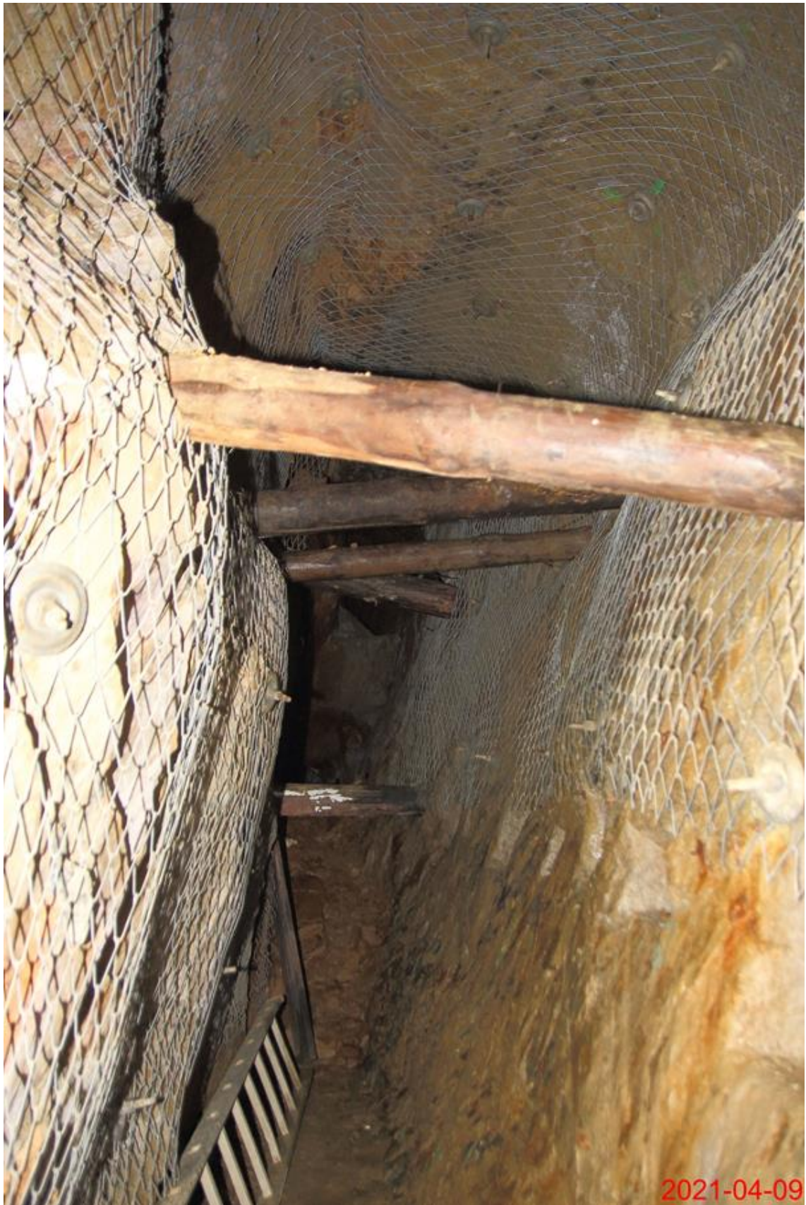
Fot. 1. Ogólny widok na komorę eksploatacyjną (sposób zabezpieczenia)
