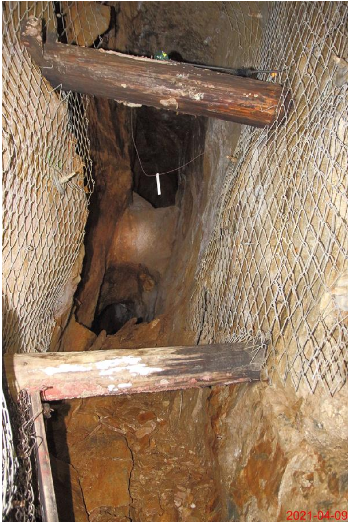
Fot. 2. Widok na pryzmę z luźnych skał pochodzących z obwálu oraz na rozpory wygrozdzeniowe
