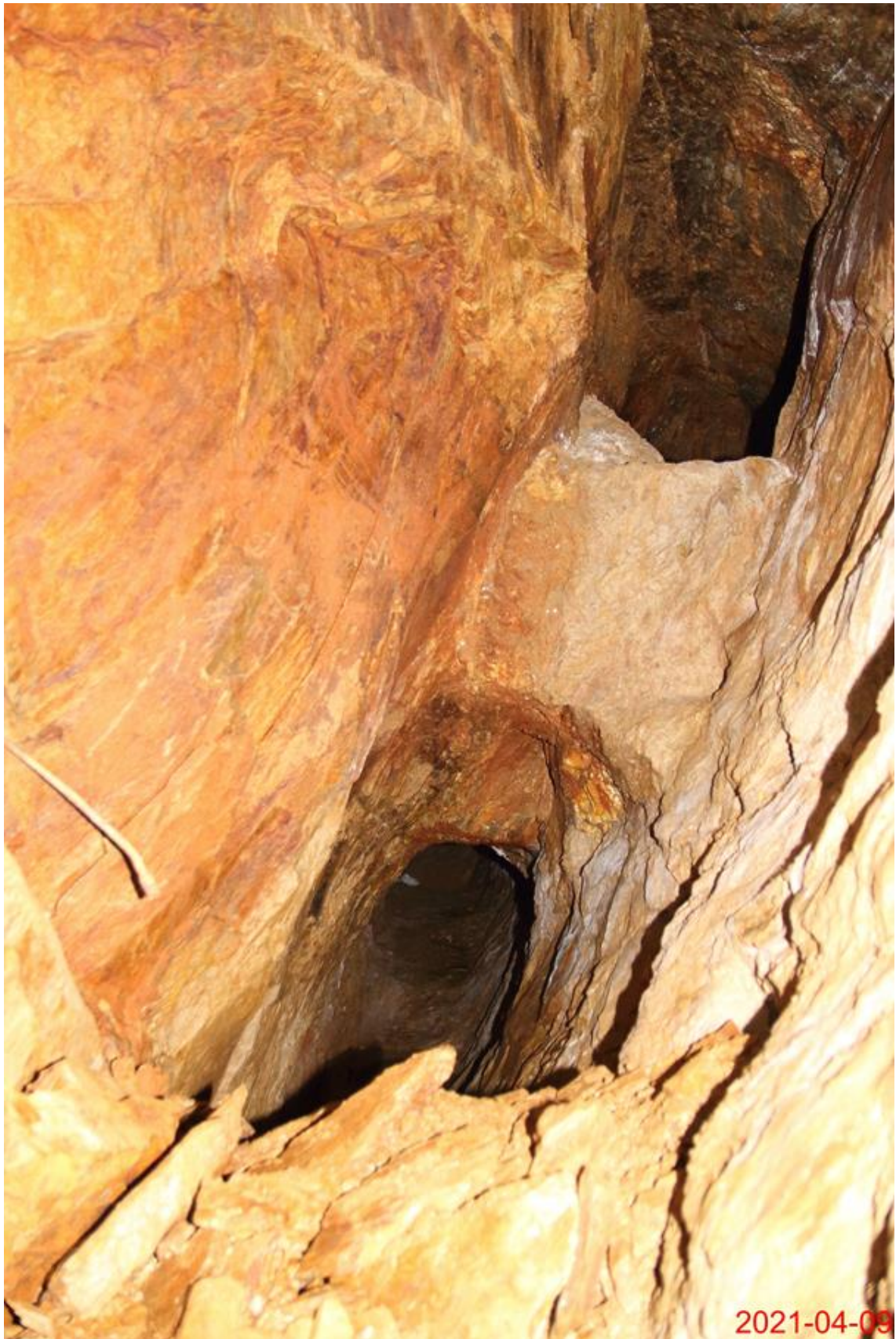
Fot. 6. Widok na ocios północny, wiszący. Widok na chodnik eksploatacyjny dolny. Widoczna również wystająca z północnego ociosu żerdź kotwy.
