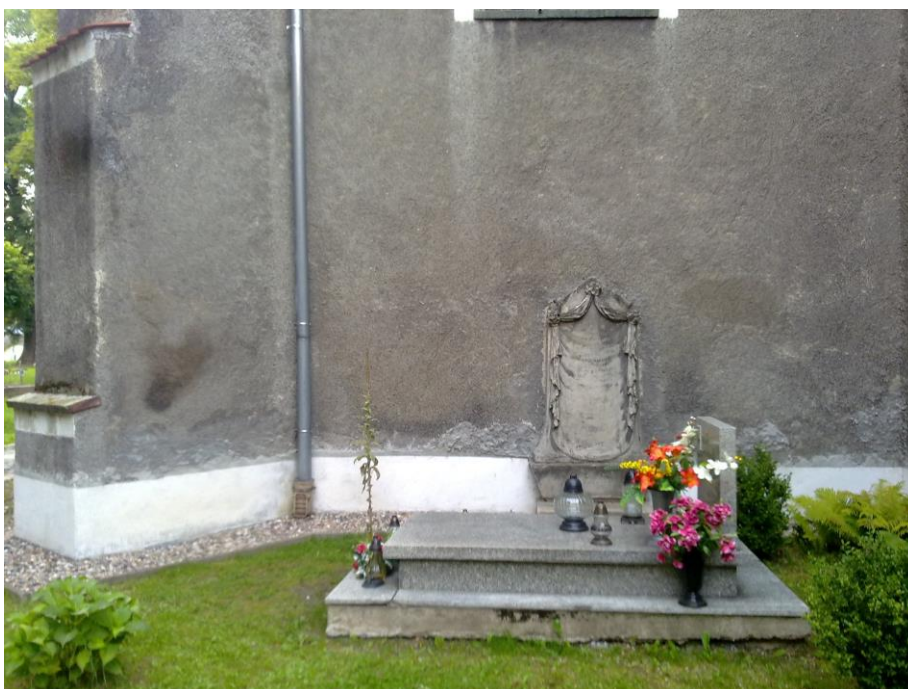
Fot.5. fragment elewacji południowo-zachodniej
