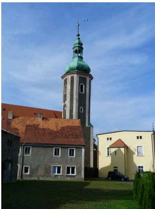
fot.1. stan obecny(2014r.)- widok od południa
