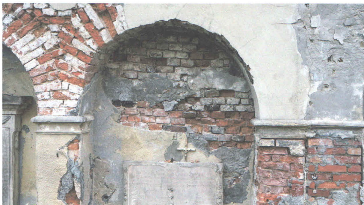
Fot,31, Stan zachowania obiektu przed konserwacją. 2018r.
