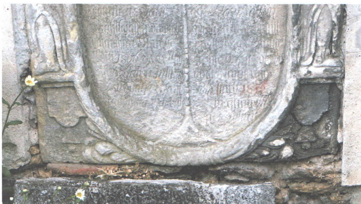
Fot,12, Stan zachowania obiektu przed konserwacją. 2018r.
